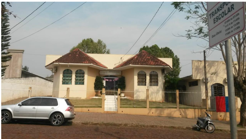
Figura 2. Fachada do Centro Municipal de Educação Infantil São Francisco de Assis, município de Dois Vizinhos, Paraná.
