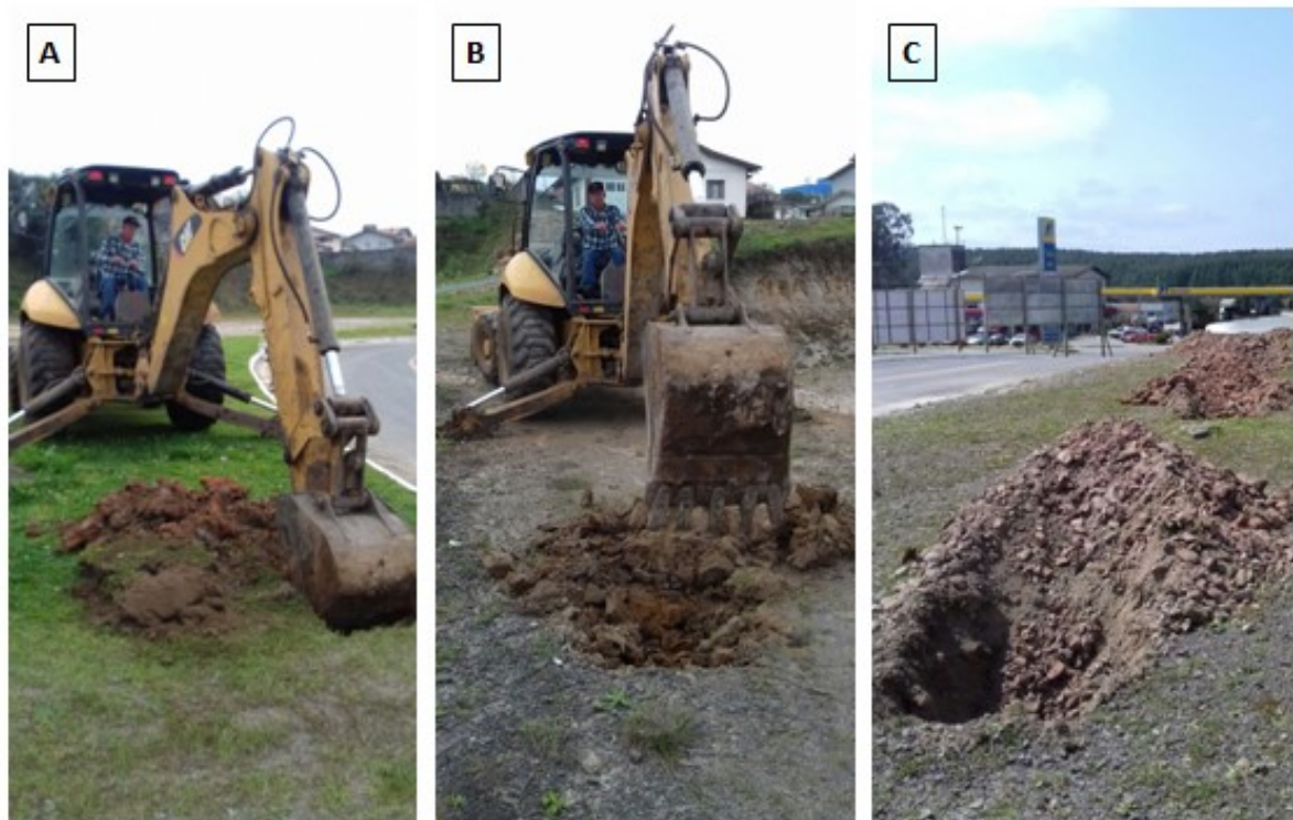
Figura 33 – A e B) Abertura das covas com auxílio da retroescavadeira; C) Covas abertas. Fonte: O Autor, 2017.
