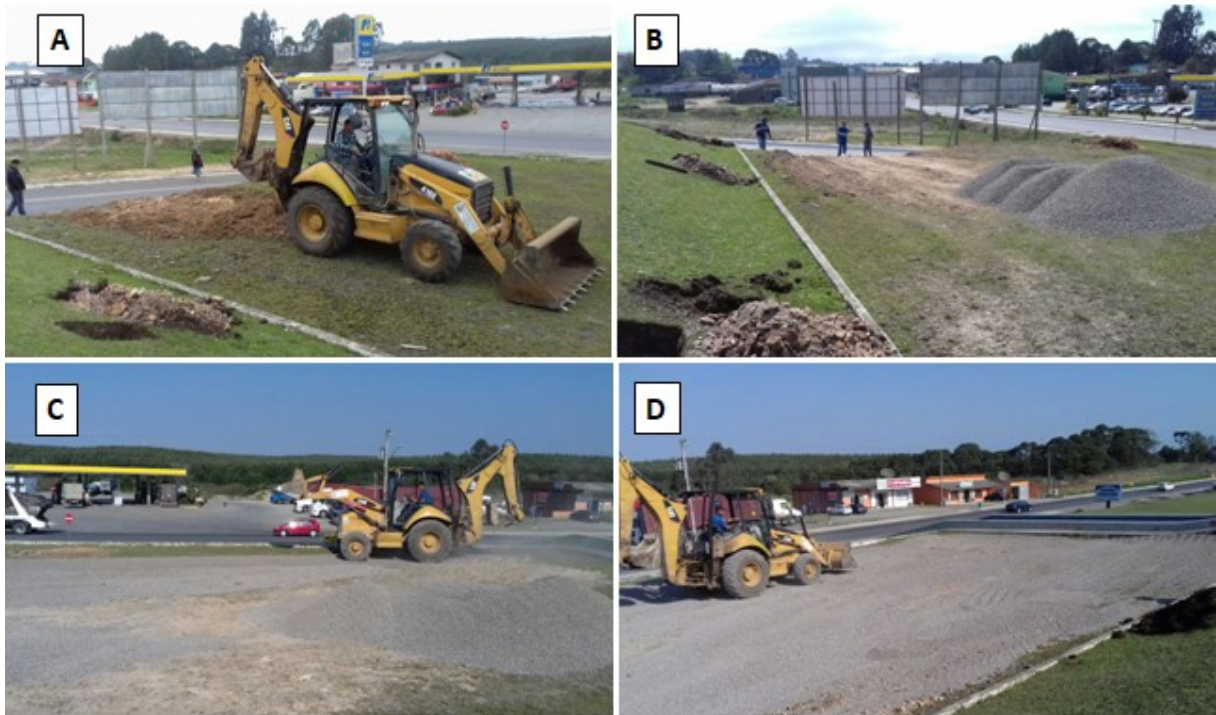
Figura 36 - Construção do novo estacionamento: A) Abertura de acesso ao estacionamento; B) Pedra brita para recobrimento da área; C) Distribuição da pedra na área; D) Nivelamento da pedra na área.
