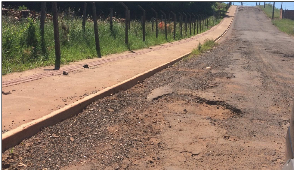
Figura 36 - Calçadas executadas inteiramente em concreto. Fonte: A Autora. 2015.
