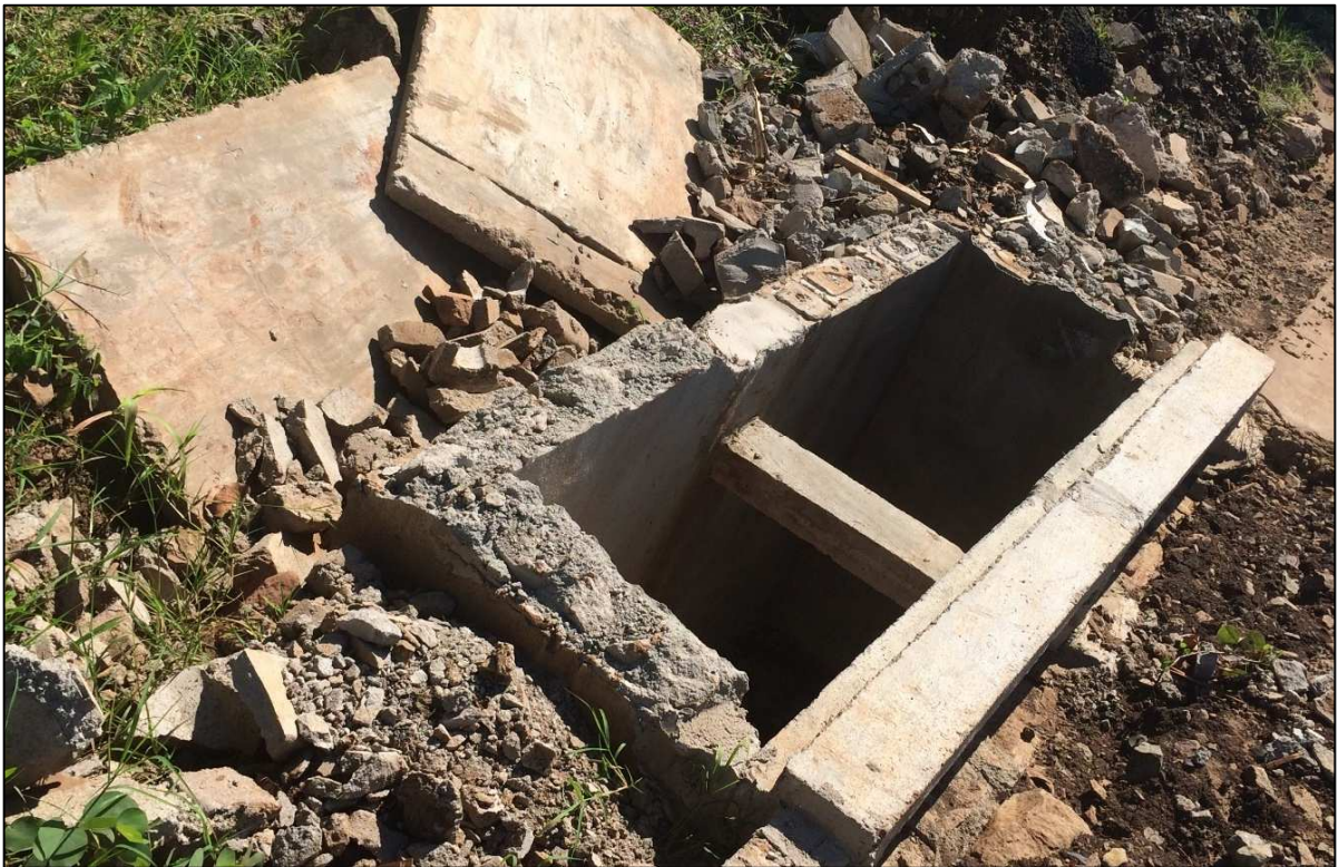
Figura 45 - Boca de lobo acima do nível sendo reparada. Fonte: A Autora. 2015.
