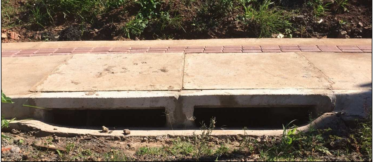
Figura 46 - Boca de lobo dupla em condições ideais. Fonte: A Autora. 2015.
