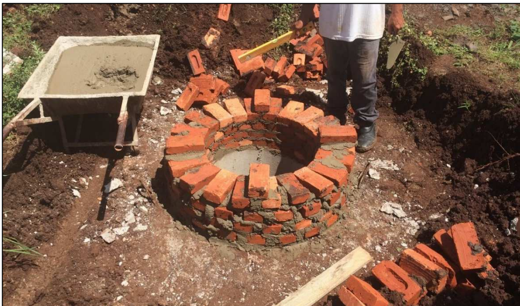
Figura 28 - Detalhe do poço de visita durante a execução. Fonte: A Autora. 2015.
