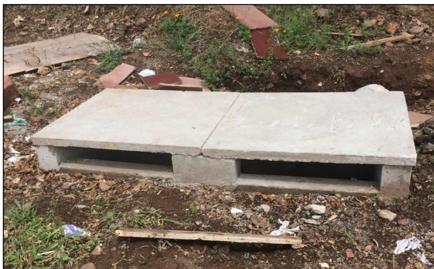
Figura 31 - Boca de lobo dupla finalizada. Fonte: A Autora. 2015.
