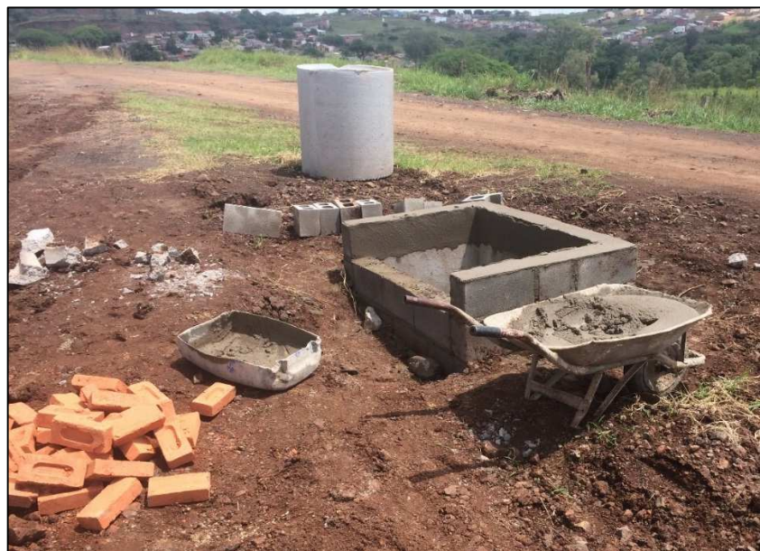
Figura 30 - Boca de lobo em execução. Fonte: A Autora. 2015.
