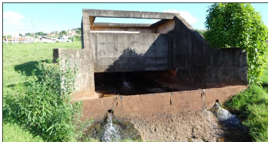
Figura 22 - Vista frontal do dissipador existente. Fonte: Empresa Executora da Obra. 2014
