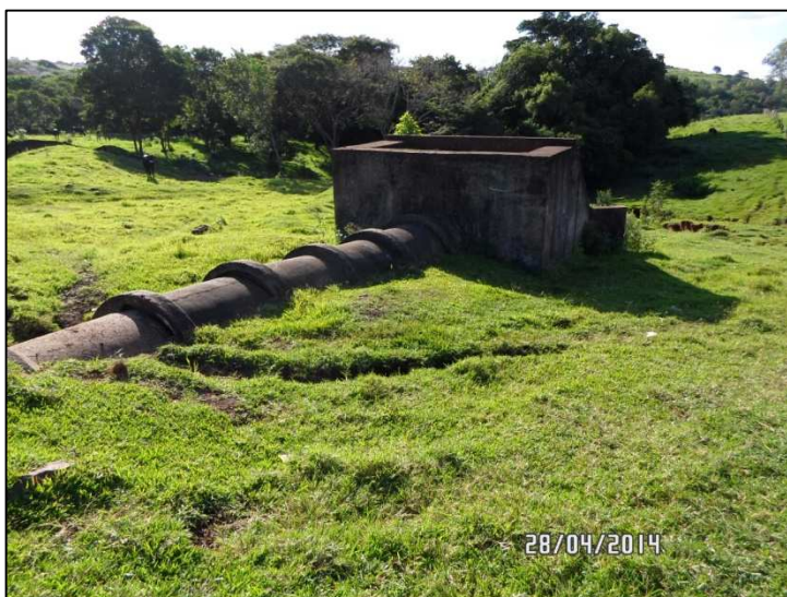
Figura 23 - Vista posterior do dissipador existente. Fonte: Empresa Executora da Obra. 2014.
