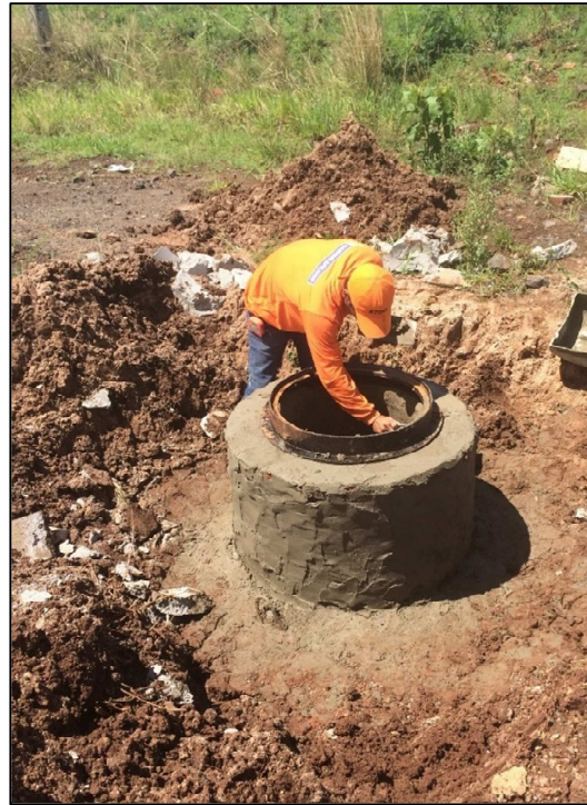
Figura 29 - Acabamento da saída do poço de visita. Fonte: A Autora. 2015.
