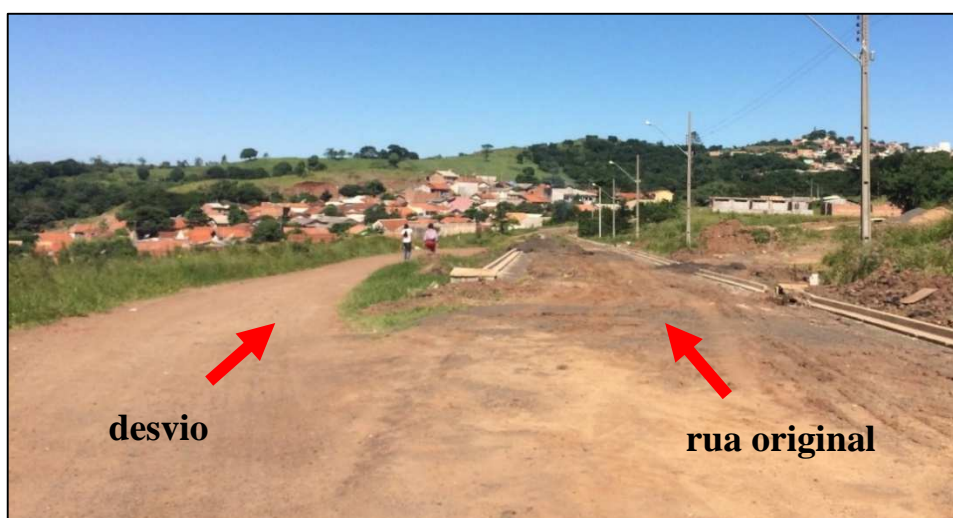
Figura 32 - Desvio executado devido às condições da rua original. Fonte: A Autora. 2015.
