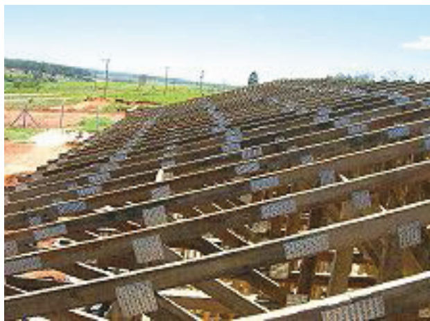
Figura 4 – Tesouras de madeira pré-fabricadas Fonte: Sacco e Stamato (2008)
