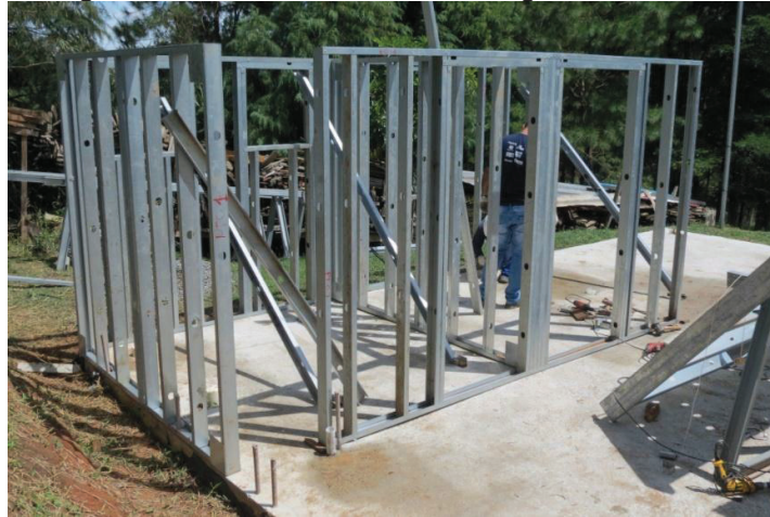
Figura 27 - Painéis estruturais em Light Steel Frame .
