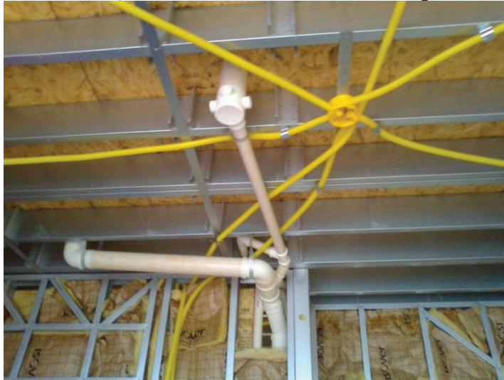
Figura 23 – Instalações Elétricas e hidrossanitárias: Light Steel Frame
