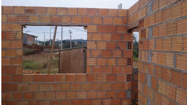
Figura 25 – Levantamento de alvenaria de blocos cerâmicos
