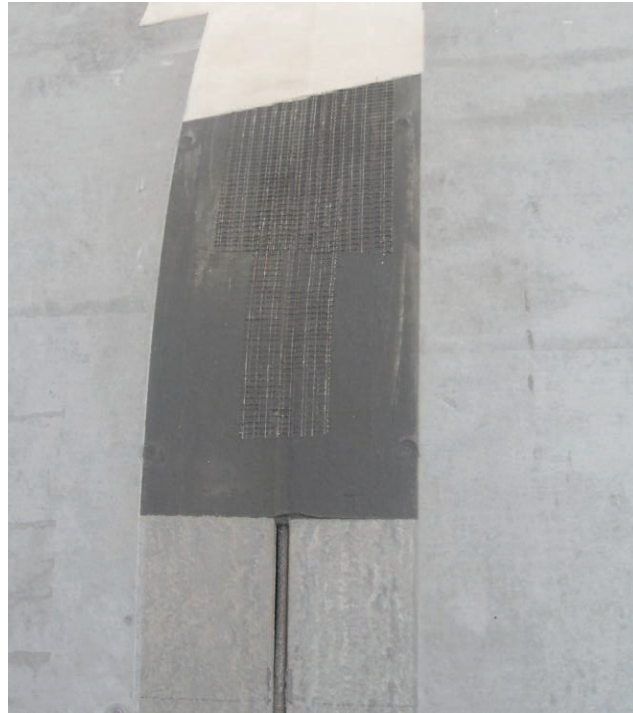
Figura 9- Tratamento de junta em placas cimentícias
