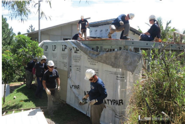
Figura 34 – Aplicação de membrana hidrófuga
