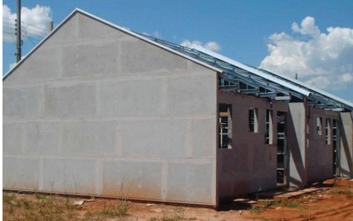
Figura 28 - Vedação de residência popular em placas cimentícias.
