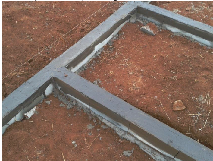
Figura 19 – Impermeabilização da viga baldrame: Alvenaria estrutural
