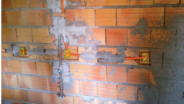
Figura 22 – Instalações elétricas e hidrossanitárias: Alvenaria convencional
