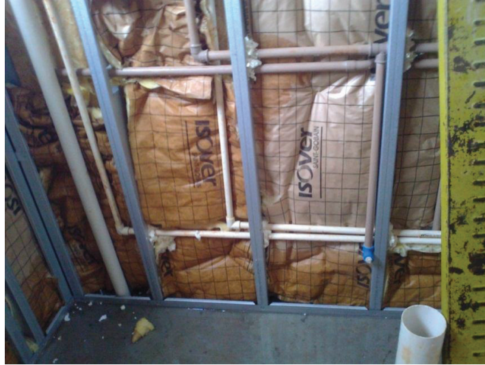
Figura 24 – Instalações hidrossanitárias: Light Steel Frame
