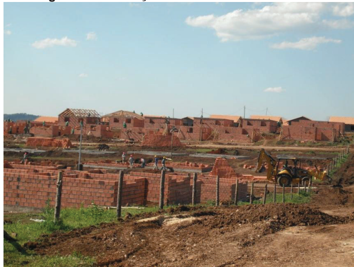
Figura 1 – Edificação em alvenaria convencional
