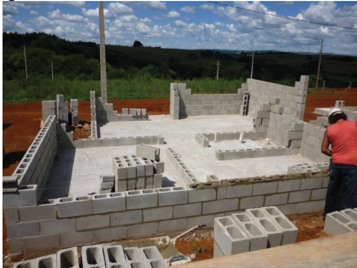
Figura 26 – Levantamento de alvenaria de blocos de concreto
