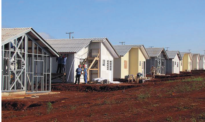
Figura 6 – Conjunto Habitacional em Light Steel Frame
