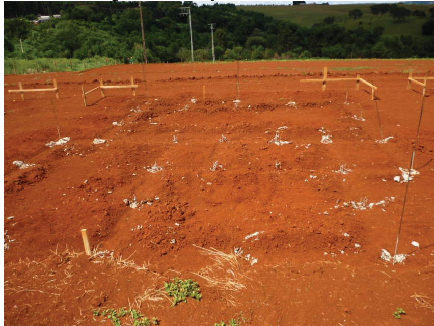
Figura 18 – Fundação em micro estacas
