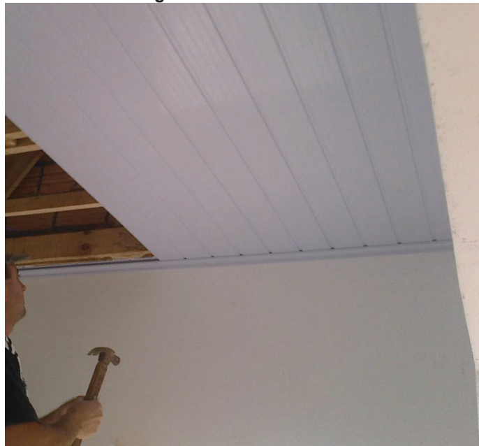
Figura 32 – Forro em PVC
