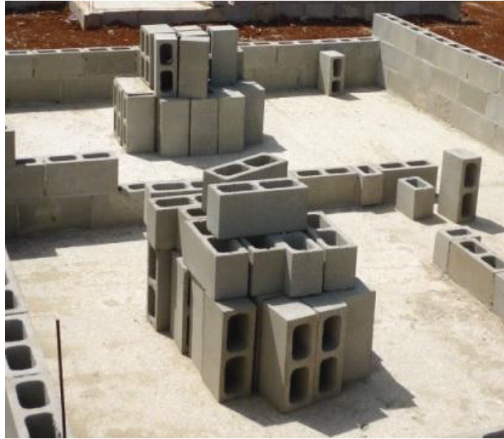
Figura 5 – Blocos estruturais com dimensões nominais 15x20x40 cm
