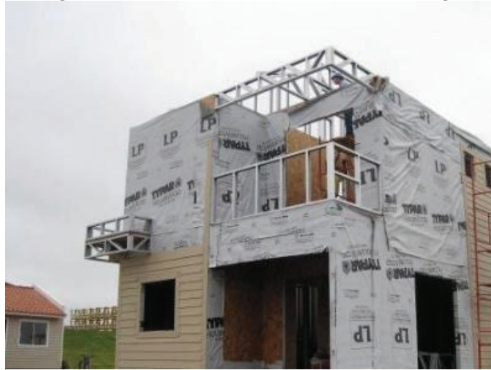
Figura 8 – Revestimento com membrana hidrófuga
