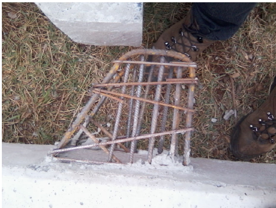
Figura 45 – Armadura do consolo após concretagem do pilar Fonte: O autor, 2013.
