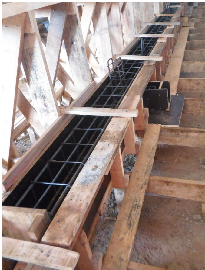
Figura 64 – Segunda lateral posicionada Fonte: O autor, 2013
