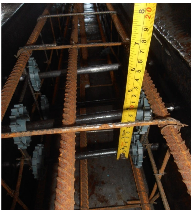
Figura 31 – Barras lisas posicionadas Fonte: O autor, 2013.
