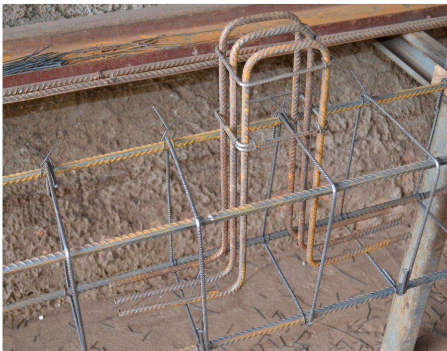
Figura 68 – Armadura para consolo cubico Fonte: O autor, 2013
