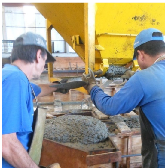
Figura 71 – Concretagem de peça e consolos em única etapa Fonte: O autor, 2013
