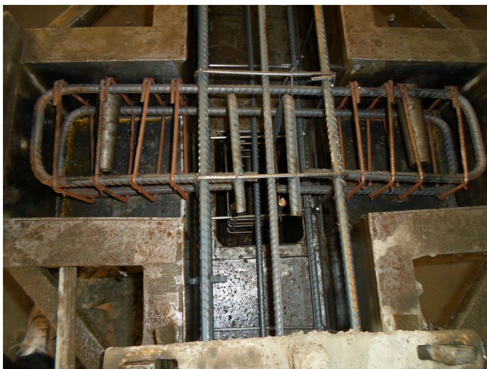
Figura 56 – Armaduras executadas para fôrmas fixas com molde para pilar com três consolos (Empresa C)
