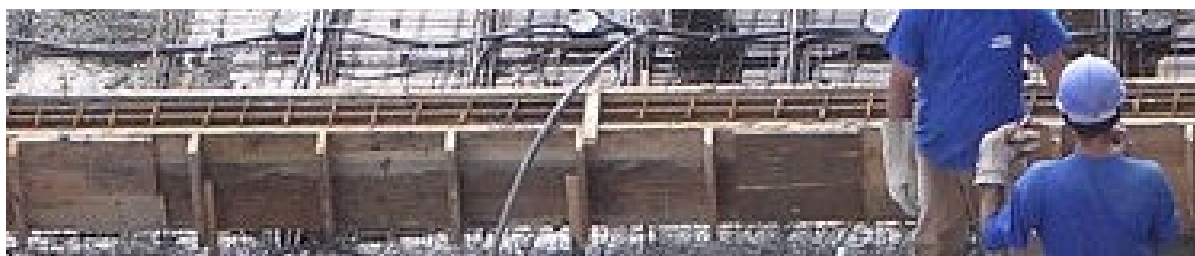
Figura 1 – Fôrma de madeira Fonte: Estrutura, UFSC, 2013.
