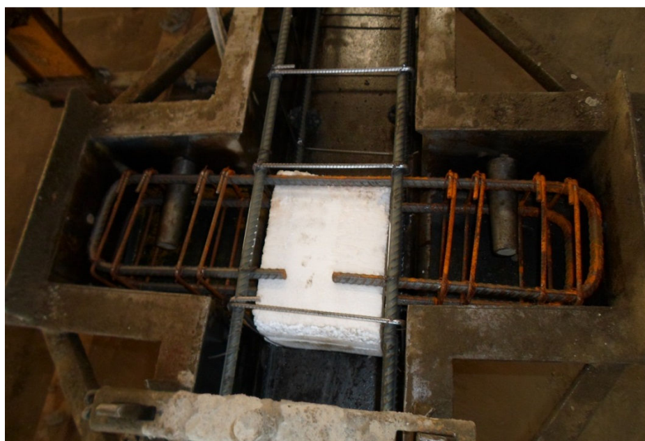
Figura 54 – Consolos armados e localizados na fôrma - modo 2 (Empresa C) Fonte: O autor, 2013.
