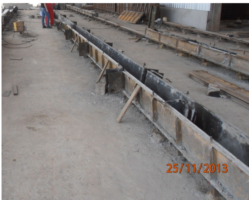
Figura 72 – Fôrmas com pontos de abertura para moldes de consolo Fonte: O autor, 2013.
