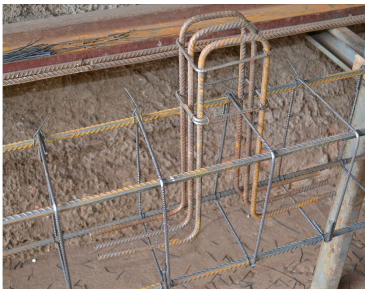
Figura 85 – Armadura padrão para consolos executada pela empresa D Fonte: O autor, 2013.
