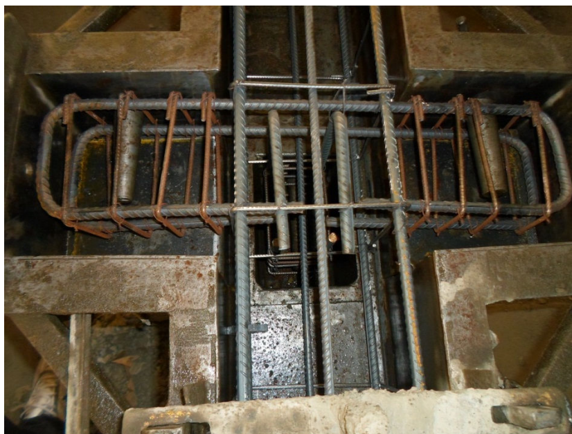
Figura 84 – Armaduras executadas para fôrmas fixas com molde para consolo (Empresa C) Fonte: O autor, 2013.
