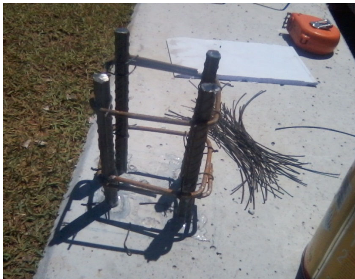
Figura 83 – Armadura executada para consolo padrão 1 da empresa B Fonte: O autor, 2013.
