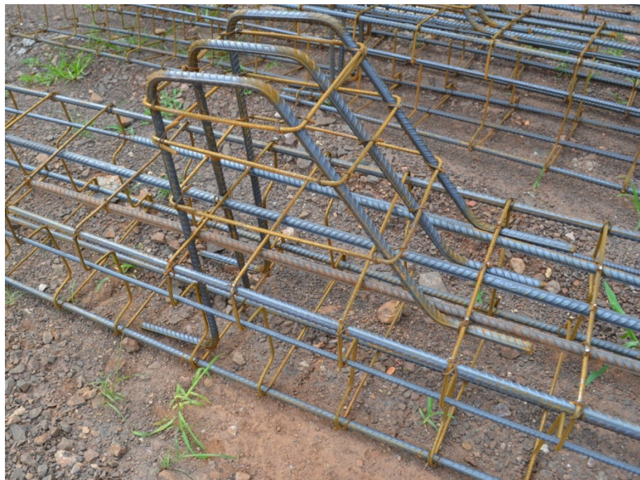
Figura 69 – Armadura para consolo misalado Fonte: O autor, 2013
