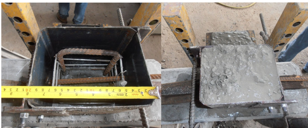
Figura 34 – Concretagem de consolo segundo o modo 1. Fonte: O autor, 2013.
