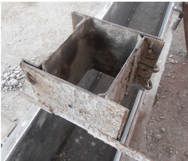
Figura 74 – Molde para consolo localizado na face superior do pilar Fonte: O autor, 2013.
