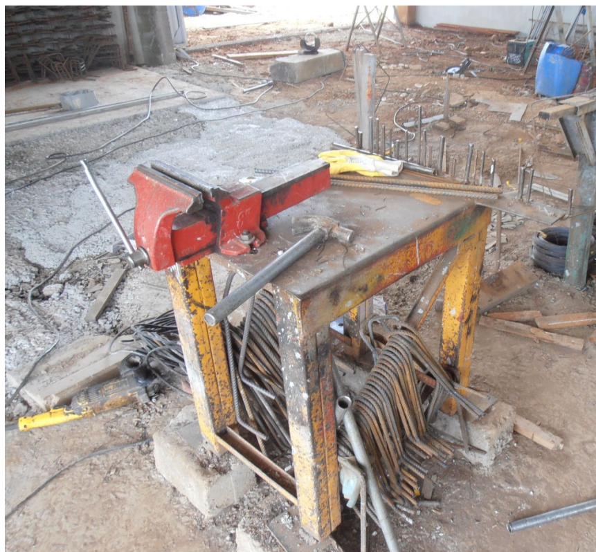
Figura 75 – Mesa para corte e dobra do aço Fonte: O autor, 2013.
