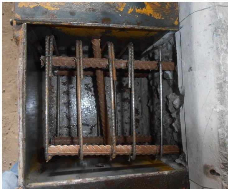
Figura 81 – Armadura executada pela empresa A Fonte: O autor, 2013.
