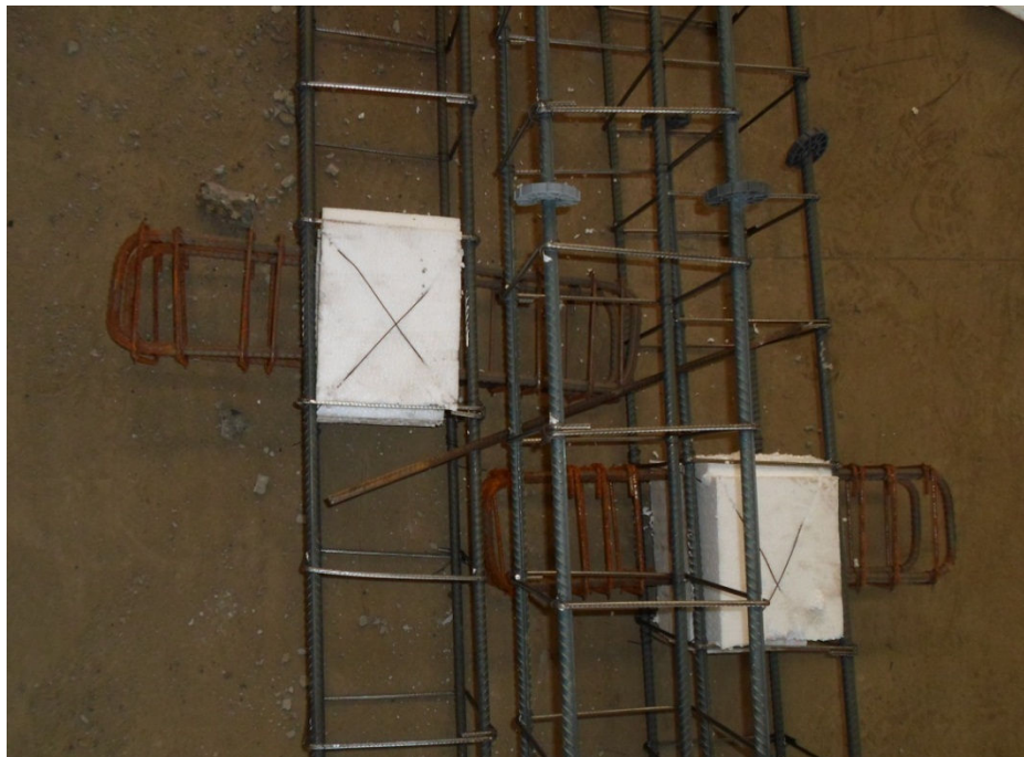
Figura 53 – Utilização do bloco de EPS para produção do consolo (Empresa C) Fonte: O autor, 2013.
