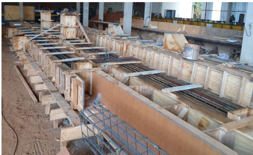
Figura 59 – Fôrmas de madeira Fonte: O autor, 2013
