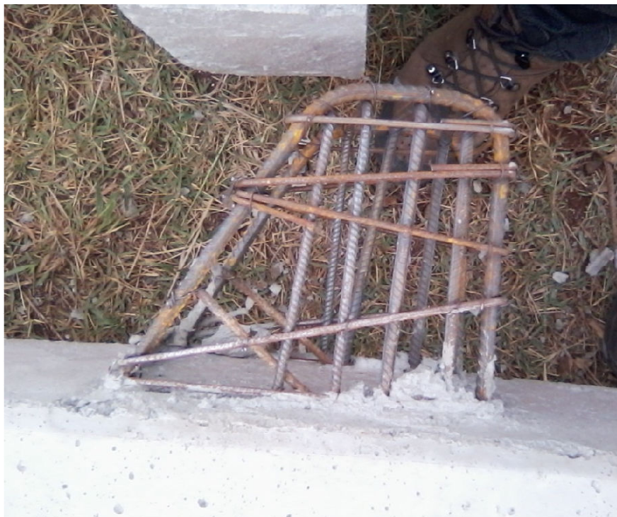
Figura 82 – Armadura executada para consolo padrão 2 da empresa B Fonte: O autor, 2013.
