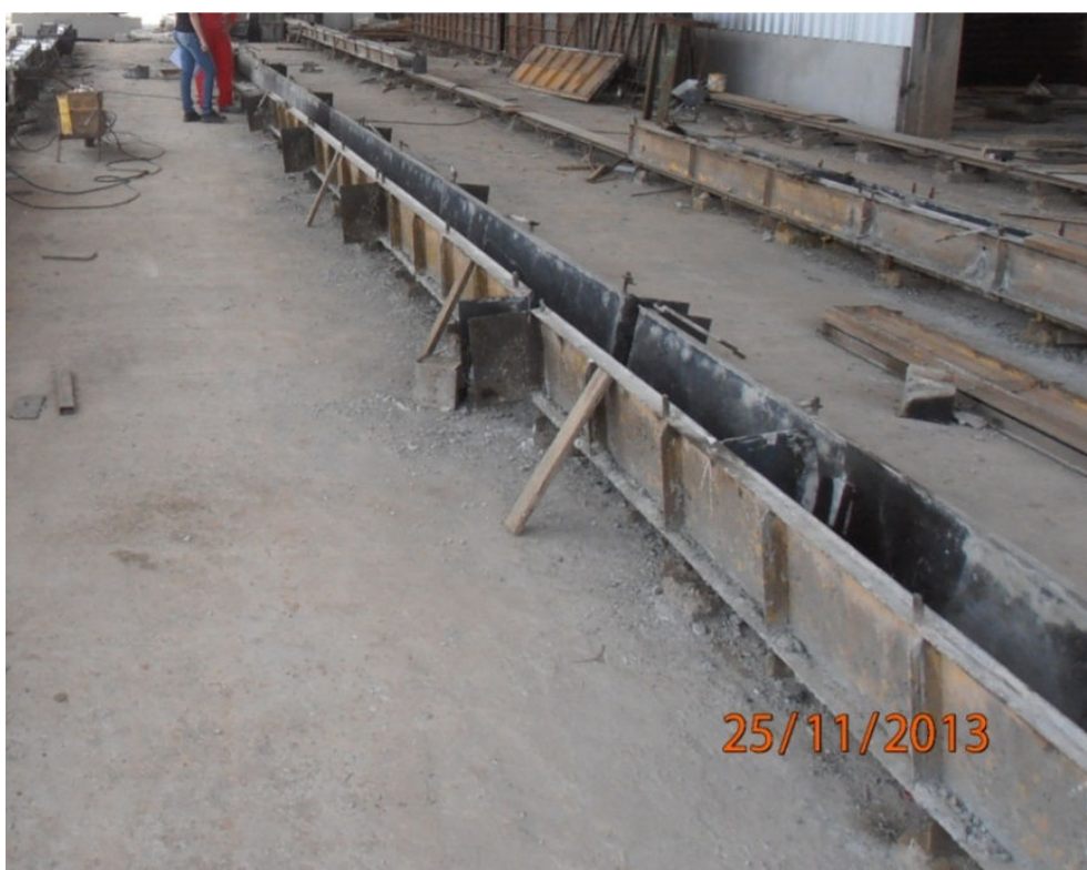
Figura 79 – Localização das fôrmas para instalação das armaduras e moldes dos consolos (Empresa E) Fonte: O autor, 2013.
