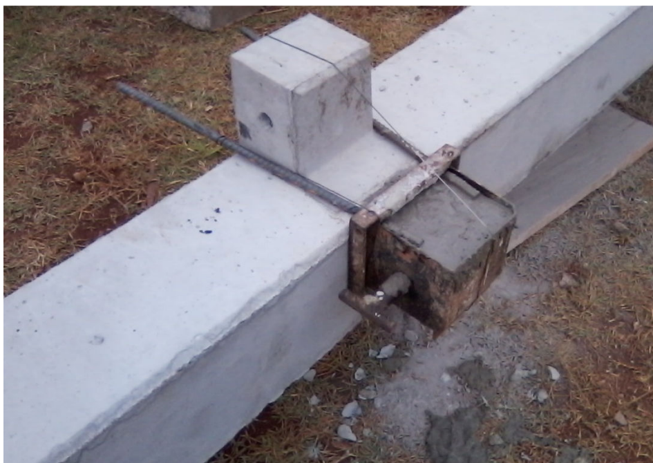
Figura 52 – Concretagem do consolo em etapa distinta Fonte: O autor, 2013.
