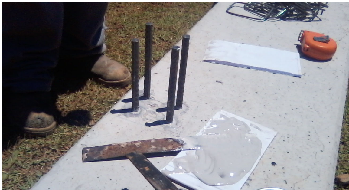
Figura 48 – Barras de aço coladas com adesivo estrutural Sikadur 32® Fonte: O autor, 2013.
