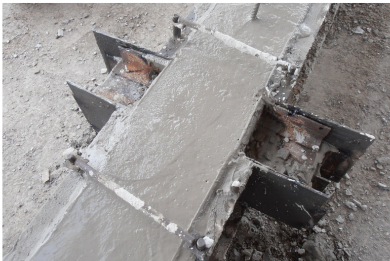
Figura 73 – Molde para consolo localizado na face lateral do pilar para concretagem Fonte: O autor, 2013.
