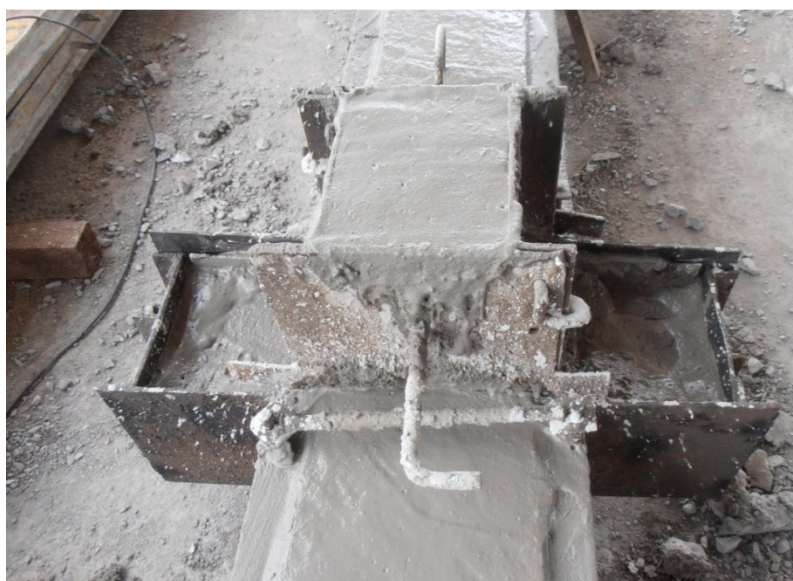
Figura 78 – Concretagem dos consolos em simultâneo com o pilar Fonte: O autor, 2013.
