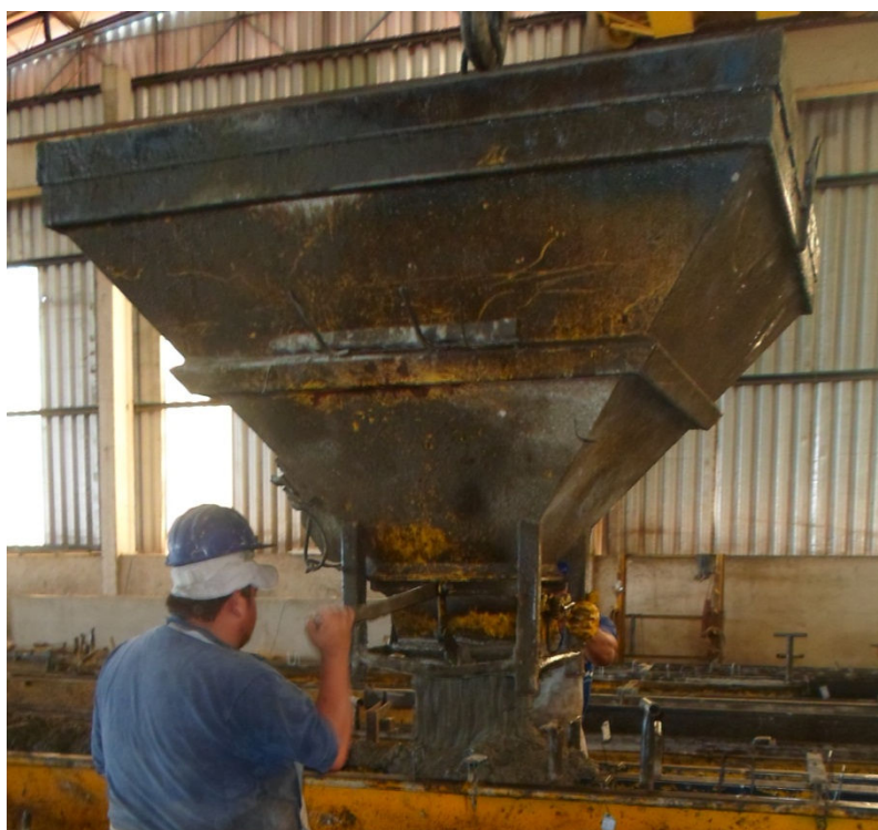
Figura 58 – Concretagem dos consolos Fonte: O autor, 2013.
