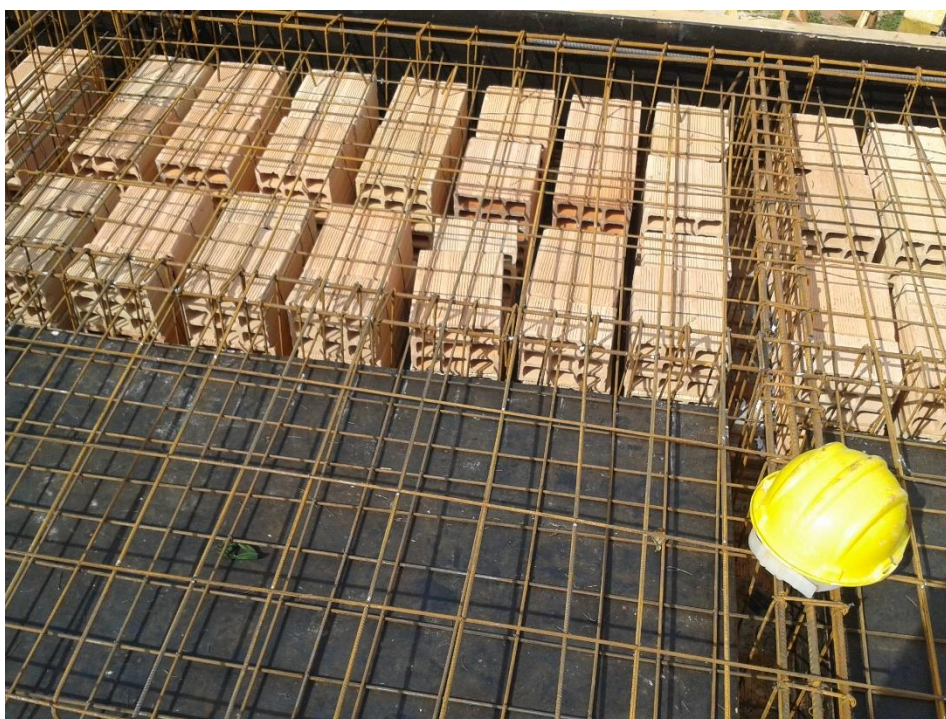
Figura 69: Detalhe da solução aplicada para atender projeto arquitetônico Fonte: Autoria Própria (2015).
