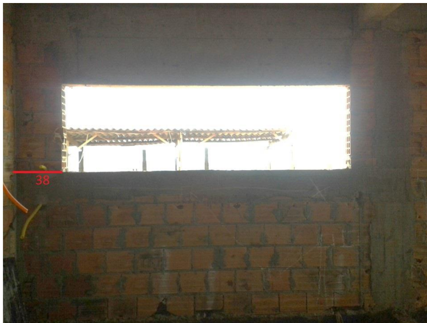
Figura 23: Medida do executado em obra
