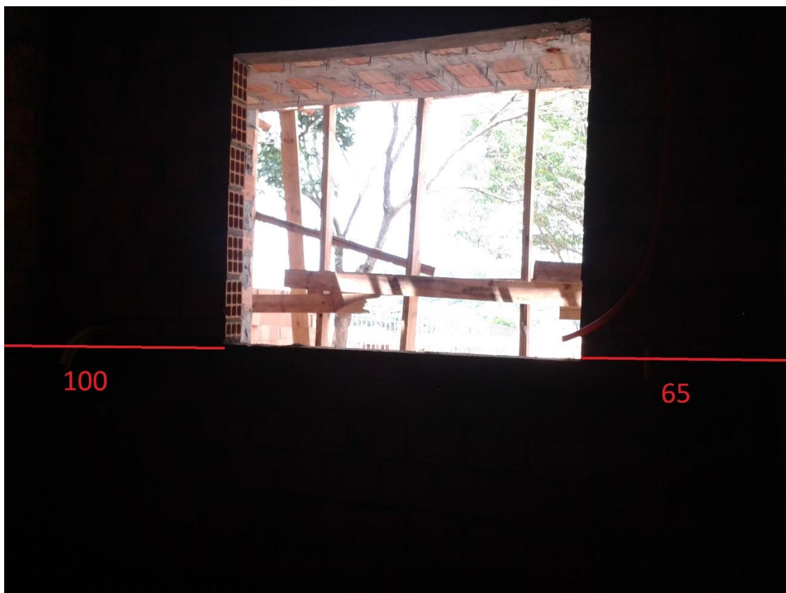
Figura 27: Medida do executado em obra
