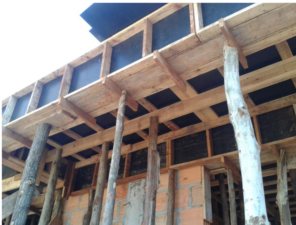
Figura 68: Alteração das formas de laje na obra Fonte: Autoria Própria (2015).
