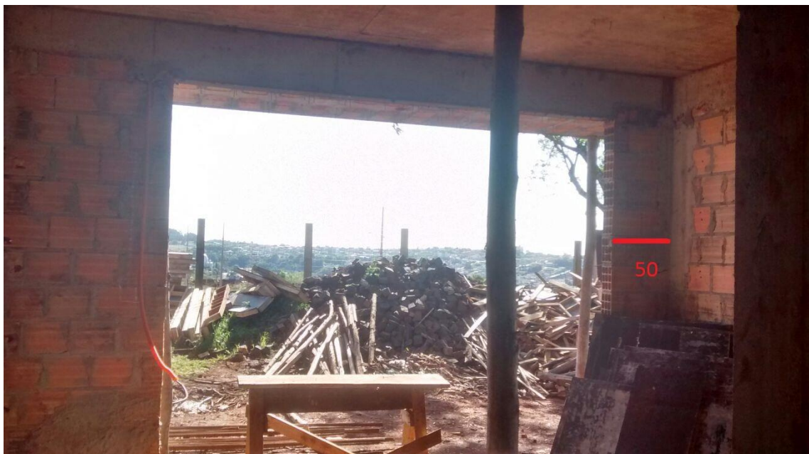
Figura 29: Medida do executado em obra Fonte: Autoria Própria (2015).
