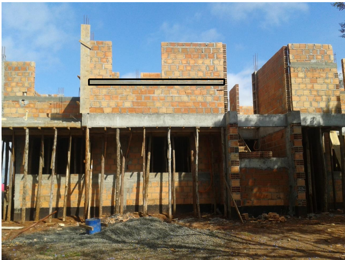
Figura 71: Demonstração das vergas
