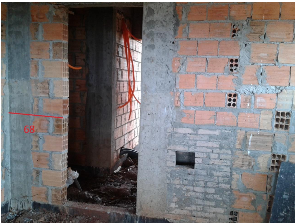
Figura 25: Medida do executado em obra
