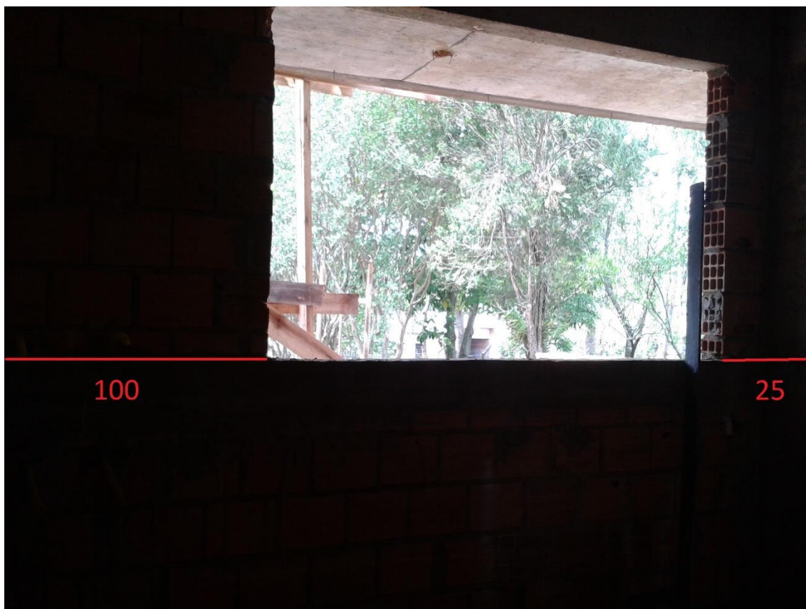
Figura 21: Medida do executado em obra
