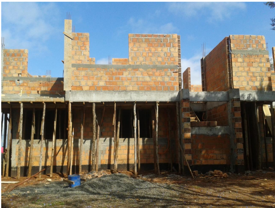
Figura 63: Elevação frontal da obra
