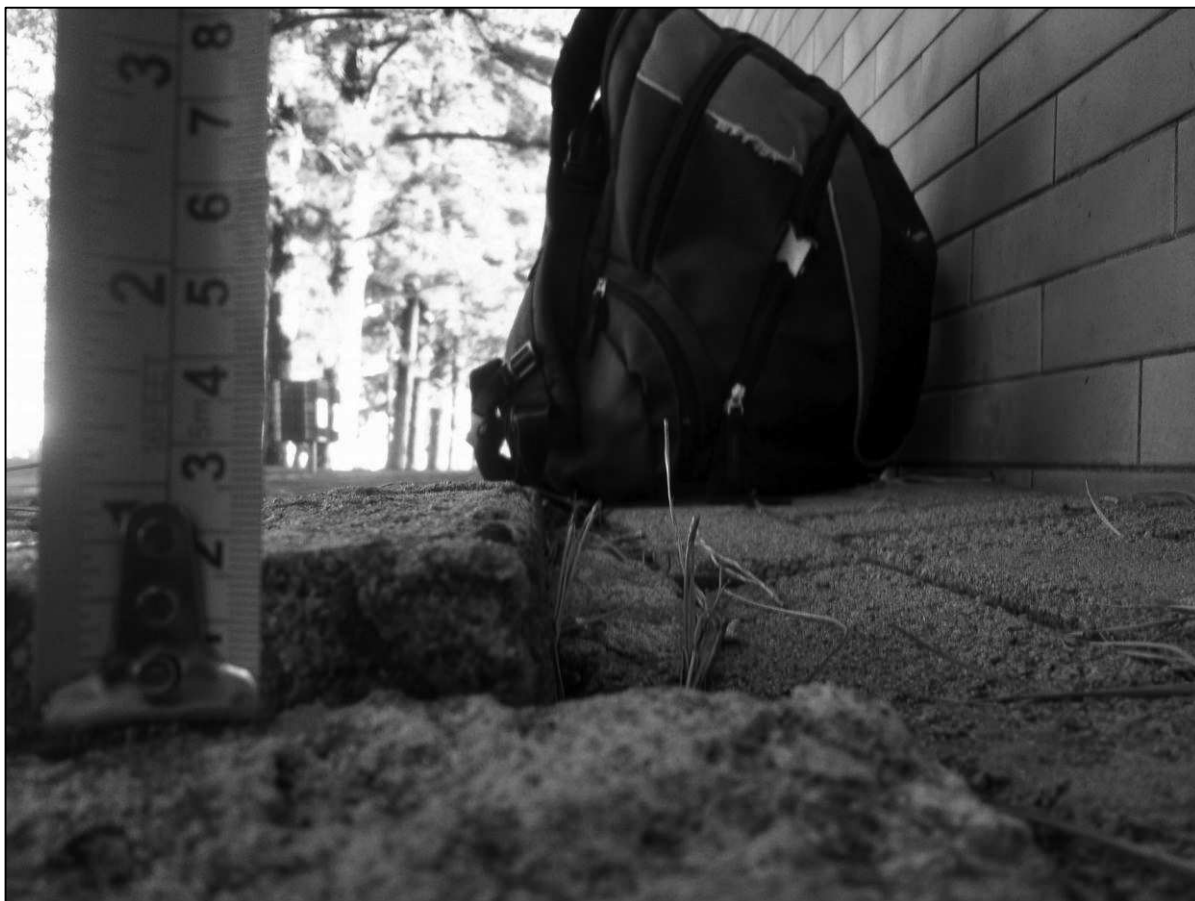
Fotografia 16 – Elevação da tampa GB2
