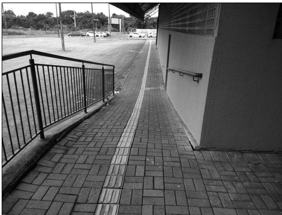
Fotografia 1 – Rampa que liga o acesso principal do estacionamento à biblioteca
