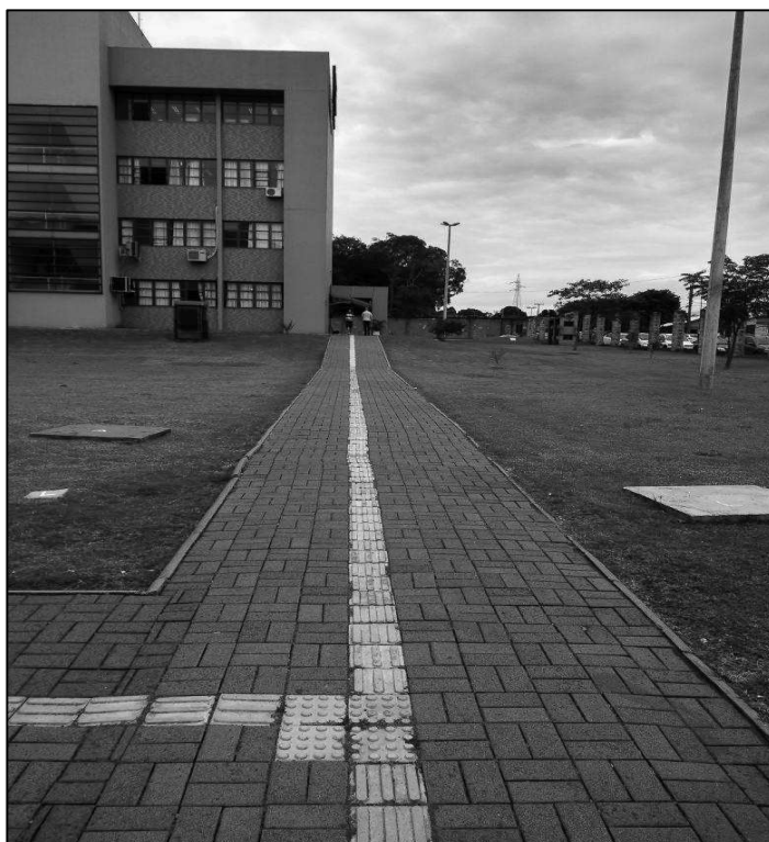
Fotografia 4 – Trechos de rampas de ligação entre as fachadas dos blocos A e C Fonte: Do autor (2017).
