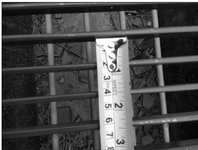
Fotografia 13 – Averiguação da fresta da grelha localizada no bloco C
