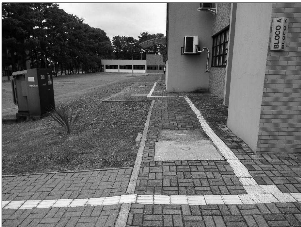
Fotografia 10 – Presença de tampas de caixas de inspeção na lateral da fachada do bloco A Fonte: Do autor (2017).
