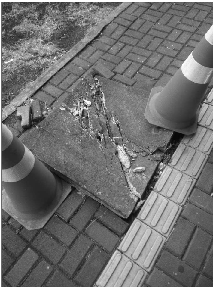
Fotografia 12 – Situação atual da tampa A8
