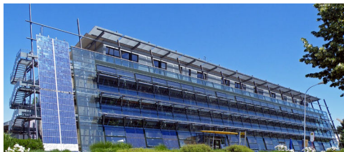
Figura 9: Solar Fabrik , Freiburg, Alemanha. Edifício de uma fábrica de painéis fotovoltaicos.
