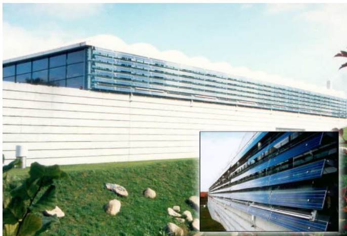
Figura 14: Edifício com aplicação de sistemas fotovoltaicos integrados a elementos de sombreamento de fachadas. Local: Alemanha. Fonte: SINAPIS, 2013.
