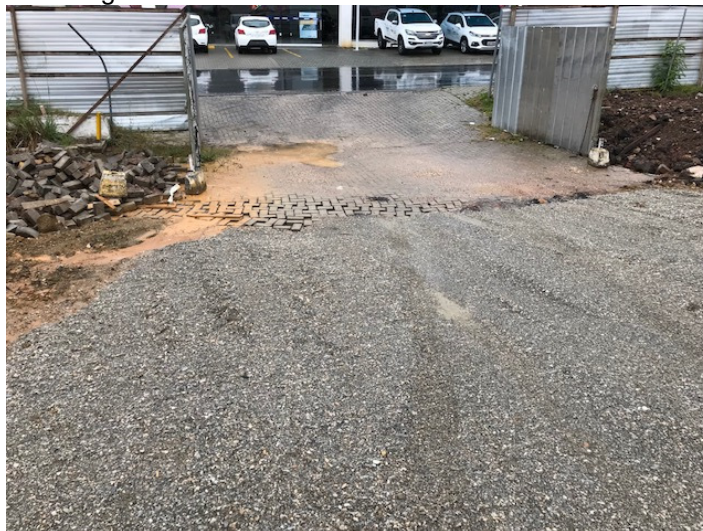
Figura 22 - Acesso ao canteiro de obras
