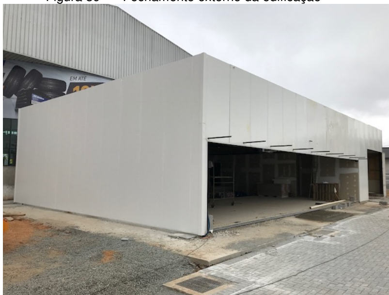
Figura 39 - Fechamento externo da edificação
