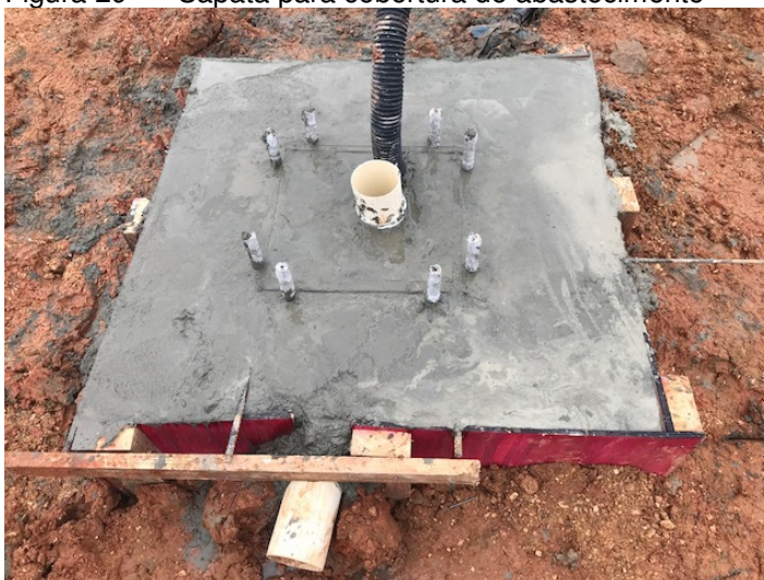
Figura 29 - Sapata para cobertura de abastecimento
