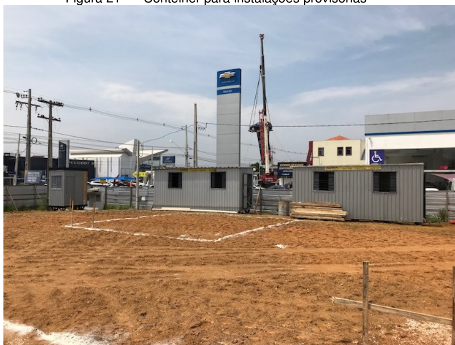
Figura 21 - Contêiner para instalações provisórias
