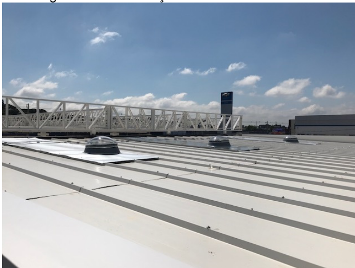
Figura 37 - Instalação domus no telhado
