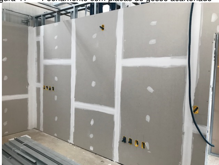
Figura 41 - Fechamento com placas de gesso acartonado
