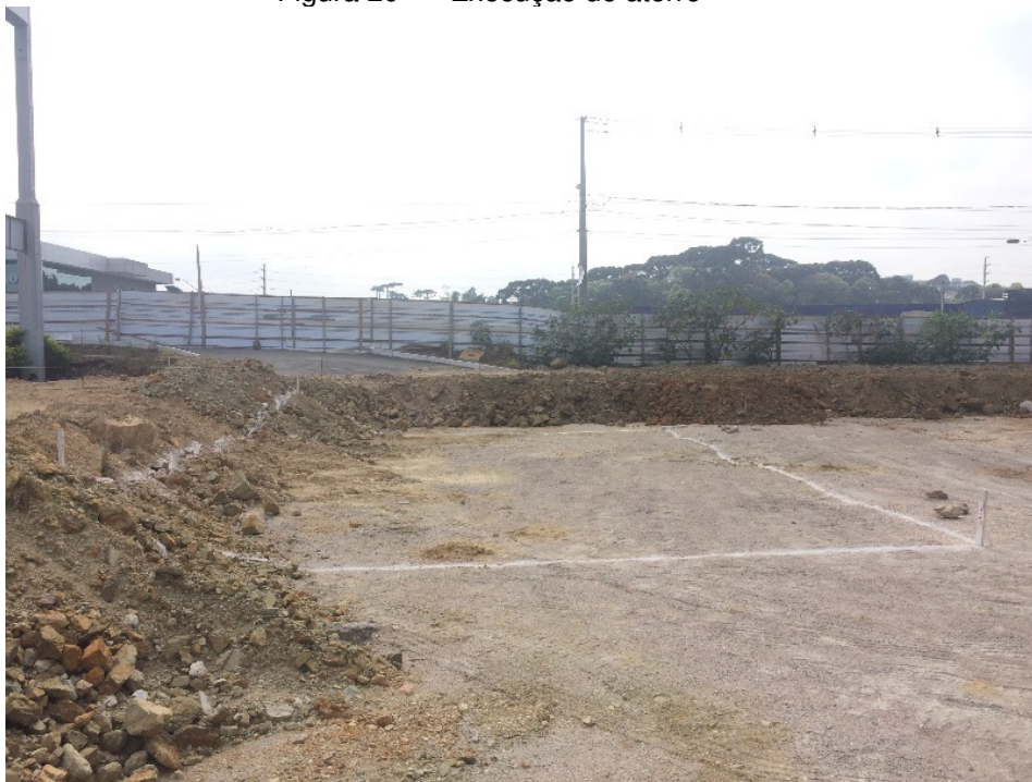
Figura 20 - Execução de aterro
