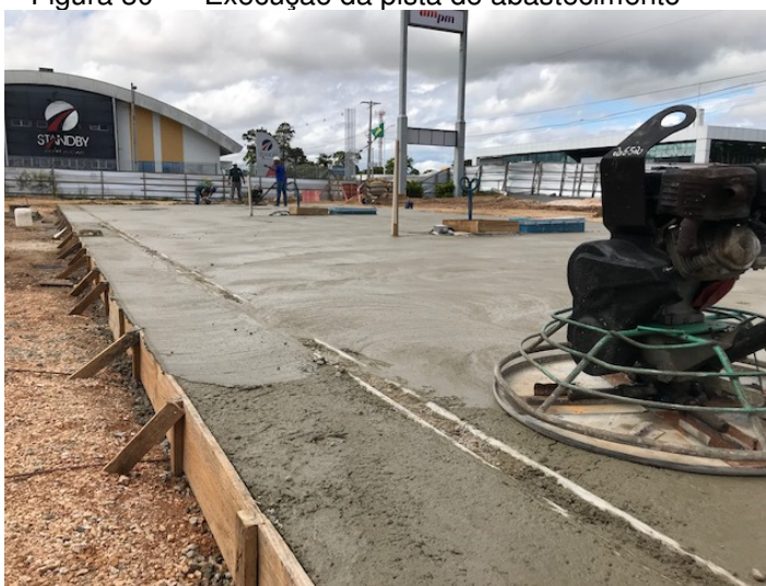
Figura 30 - Execução da pista de abastecimento
