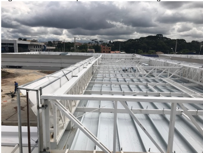
Figura 33 - Vista Superior da Cobertura Single Deck
