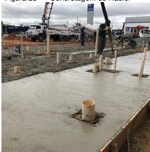
Figura 28 - Concretagem do Radier
