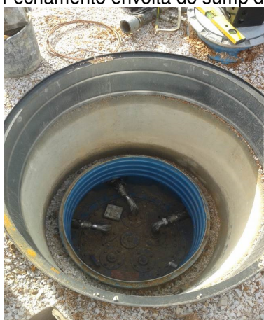
Figura 26 - Fechamento envolta do sump de tanque
