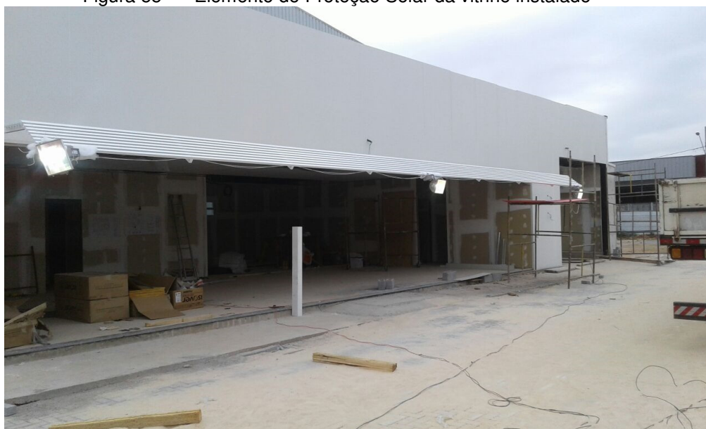
Figura 55 - Elemento de Proteção Solar da vitrine instalado
