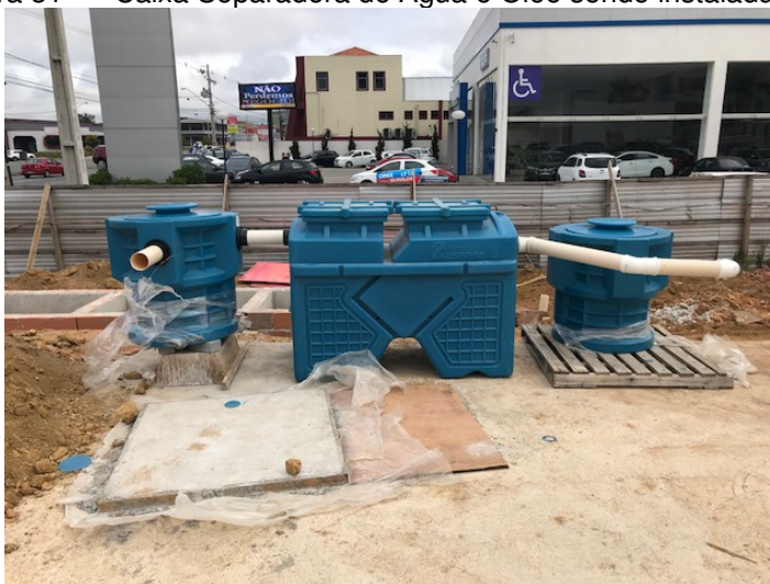
Figura 31 - Caixa Separadora de Água e Óleo sendo instalada
