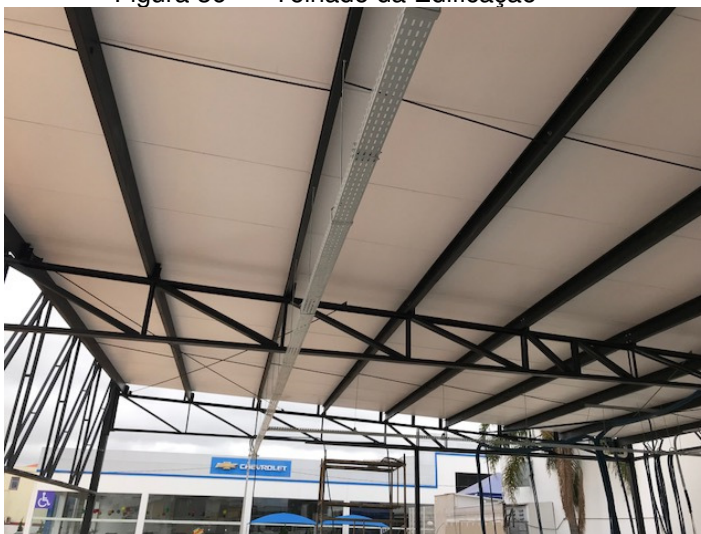
Figura 36 - Telhado da Edificação
