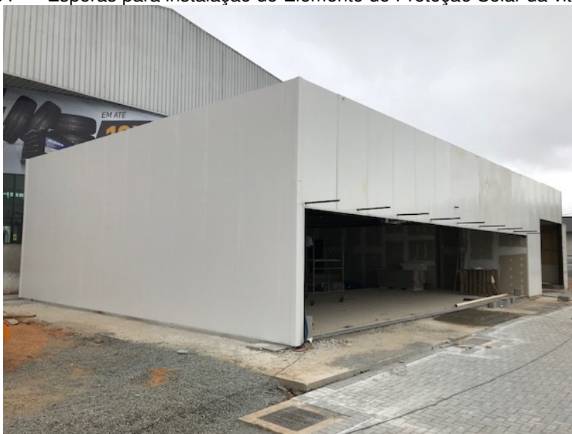
Figura 54 - Esperas para instalação do Elemento de Proteção Solar da vitrine
