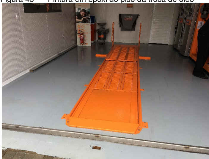
Figura 45 - Pintura em epóxi do piso da troca de óleo
