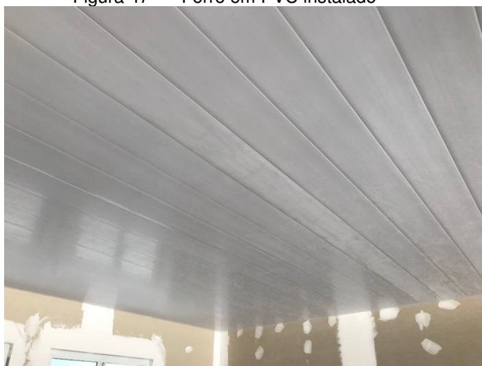
Figura 47 - Forro em PVC instalado
