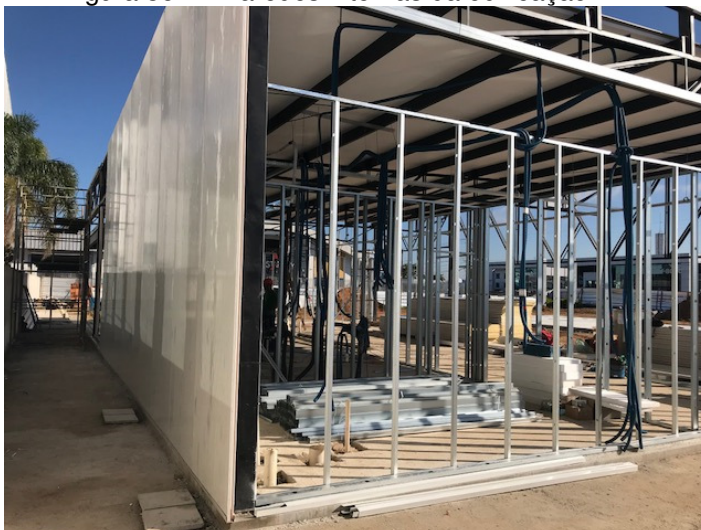
Figura 35 - Paredes internas da edificação
