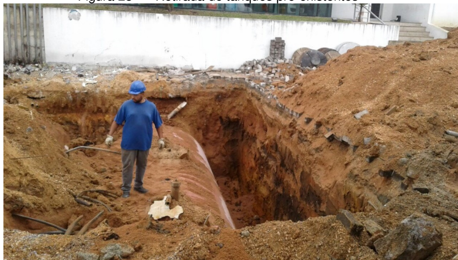
Figura 23 - Retirada de tanques pré-existentes
