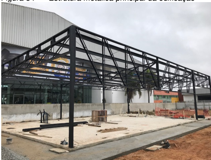
Figura 34 - Estrutura metálica principal da edificação
