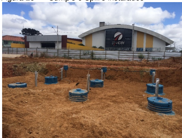
Figura 25 - Sump's e Spill's instalados
