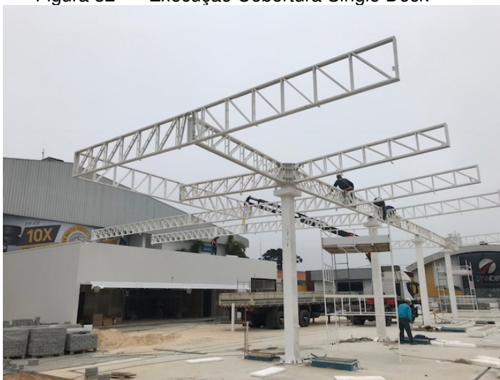
Figura 32 - Execução Cobertura Single Deck
