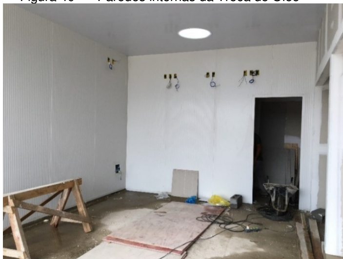
Figura 40 - Paredes internas da Troca de Óleo
