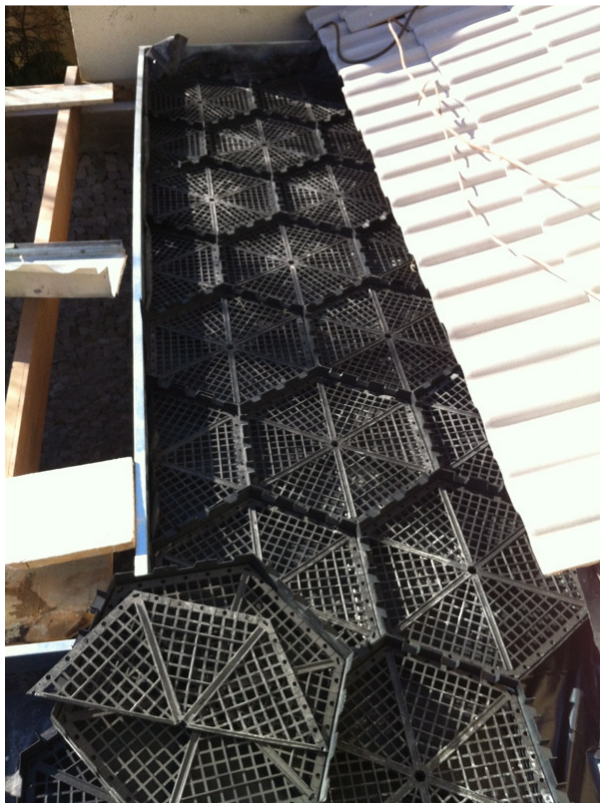
Figura 68. Detalhe dos módulos cortados e instalados.
