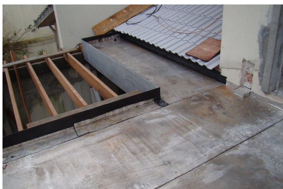
Figura 56. Impermeabilização Fonte: A autora (2012)
