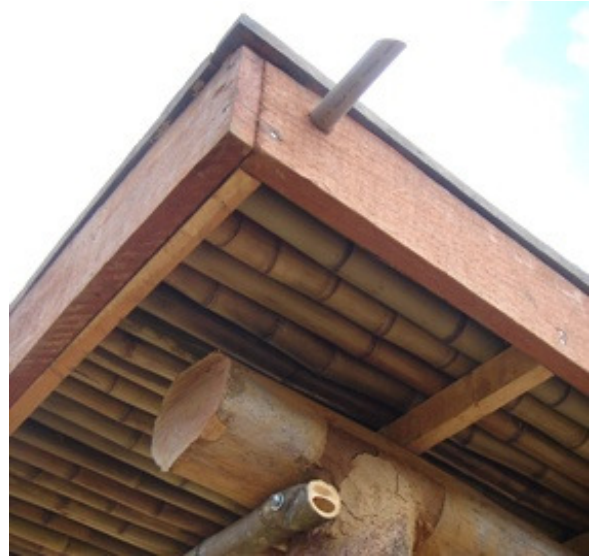
Figura 42. Telhado verde utilizando a técnica de uso de bambu. Fonte: tibarose (2012)
