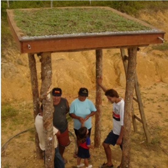
Figura 41. Protótipo de telhado verde instalado pelo Instituto Tibá Fonte: tibarose (2012)
