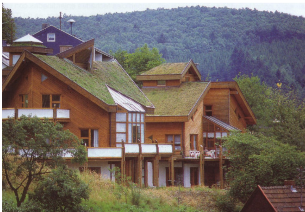
Figura 3 Telhado verde com inclinação de 45° - Siegen Oberscheiden (Alemanha) Fonte: MINKE (2004)
