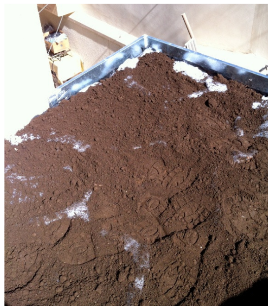
Figura 73. Colocação do Substrato sobre manta de retenção de nutrientes Fonte: A Autora (2012)
