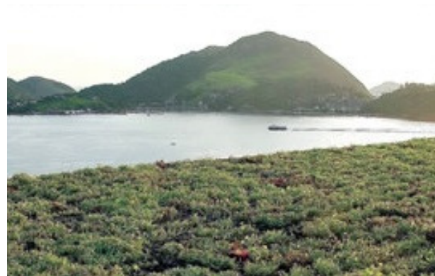
Figura 50 Vista do Telhado verde sistema modular pronto. Fonte: D'Elia (2012)
