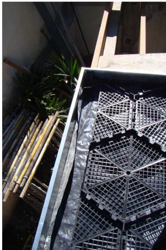
Figura 69. Detalhe dos módulos cortados e instalados.
