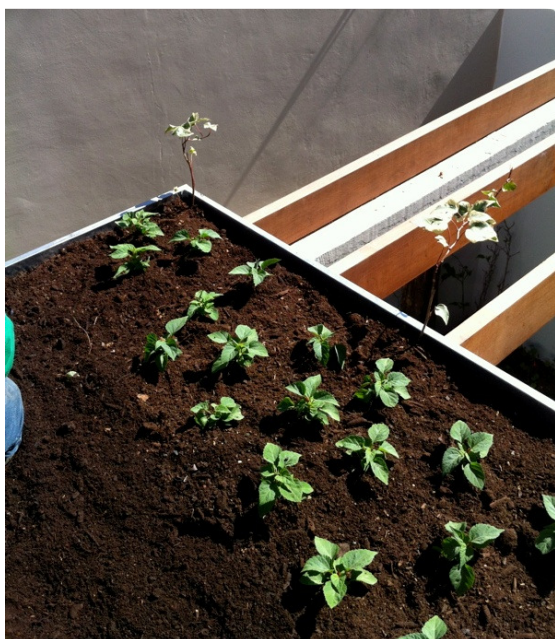
Figura 74. Colocação de vegetação sobre substrato Fonte: A autora (2012)
