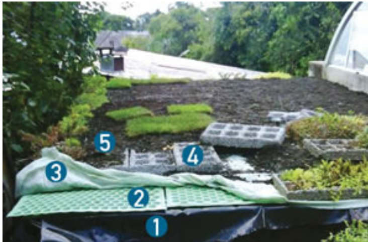
Figura 45 Camadas telhado verde sistema modular com Galocha Fonte: D'Elia (2012)
