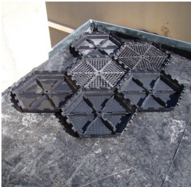
Figura 65. Instalação dos módulos para telhado verde Fonte: A autora (2012)
