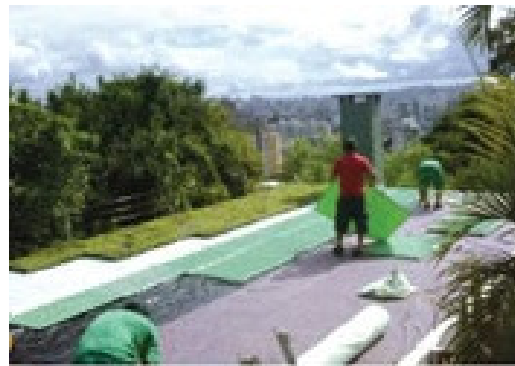
Figura 48 Membrana Alveolar aplicada Fonte: D'Elia (2012)
