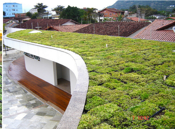
Figura 29 Telhado verde com sistema de módulos de drenagem, com a cobertura vegetada já desenvolvida. Fonte: flickr (2012)
