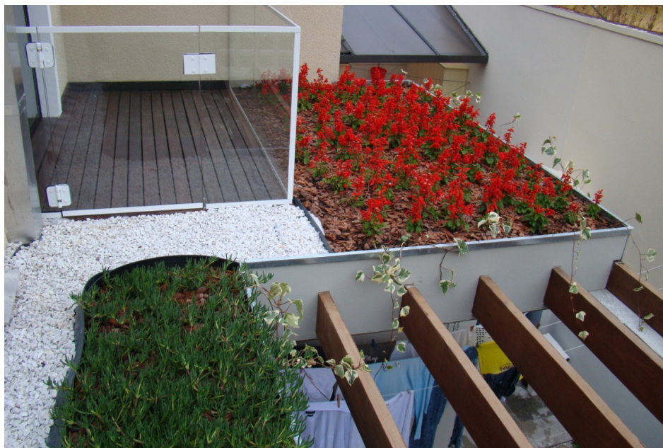
Figura 83. Vista telhado verde com 45 dias Fonte: A Autora (2012)
