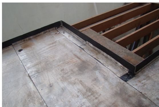
Figura 57. Impermeabilização Fonte: A autora (2012)
