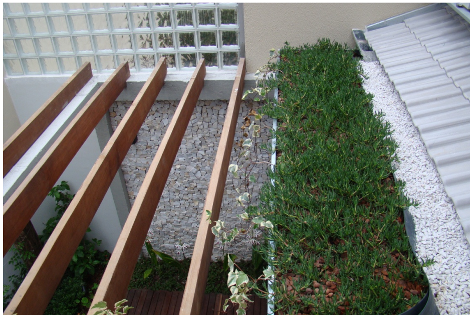
Figura 82. Vista telhado verde com 45 dias Fonte: A Autora (2012)
