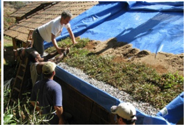
Figura 44. Montagem do Telhado verde Fonte: tibarose (2012)
