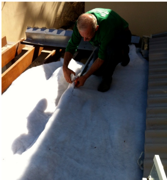
Figura 70. Instalação de manta de retenção de nutrientes. Fonte: A autora (2012)
