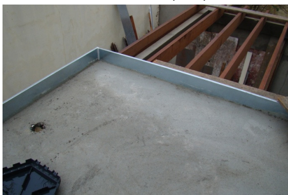
Figura 58. Contrapiso Fonte: A autora (2012)
