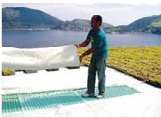
Figura 49 Aplicação da Manta de retenção de Nutrientes Fonte: D'Elia (2012)
