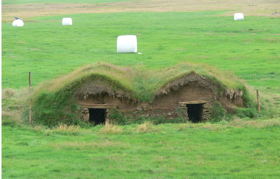
Figura 31. Residência contruída com a técnica de "Sodhouse". Fonte: wikipédia (2012)
