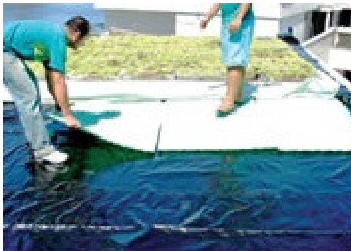
Figura 47 Aplicação da Membrana Alveolar Fonte: D'Elia (2012)
