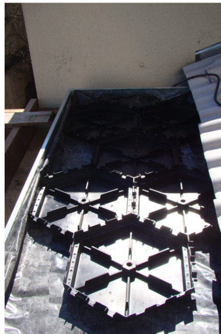
Figura 66. Instalação dos módulos para telhado verde Fonte: A autora (2012)
