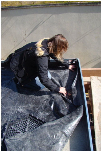
Figura 63. Instalação de lona antirraízes Fonte: A autora (2012)
