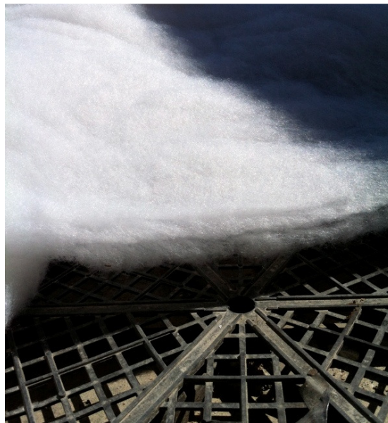
Figura 71. Instalação manta de retenção de nutrientes. Fonte: A autora (2012)
