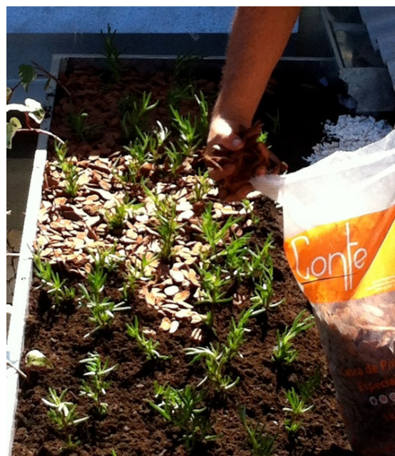
Figura 75. Colocação de casca de árvore para proteção do substrato. Fonte: A autora (2012)
