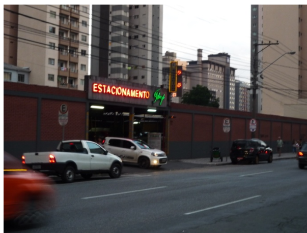
Imagem 31. Estacionamento com muros cegos de alvenaria.
