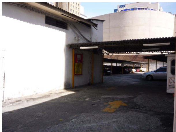
Imagem 32. Exemplo de estacionamento com cobertura simples sem fechamento. Fonte: Acervo do autor.
