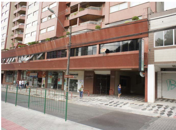
Imagem 13. Estacionamento subterrâneo localizado sob torre habitacional.
