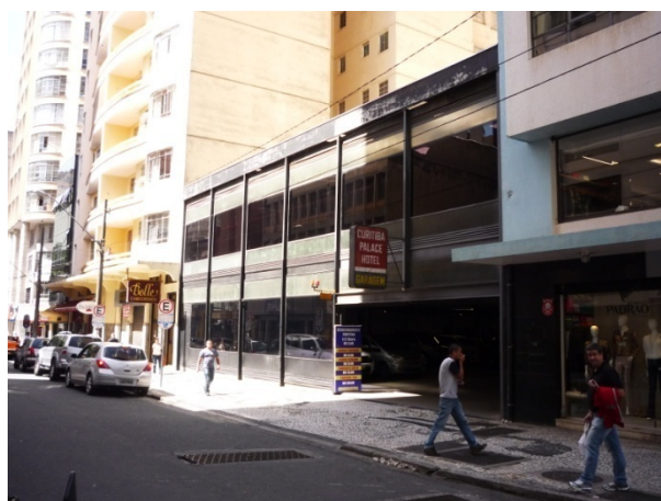
Imagem 8. Estacionamento com 2 pavimentos, coberto e estrutura adaptada do estabelecimento anterior. Fonte: Acervo do autor.
