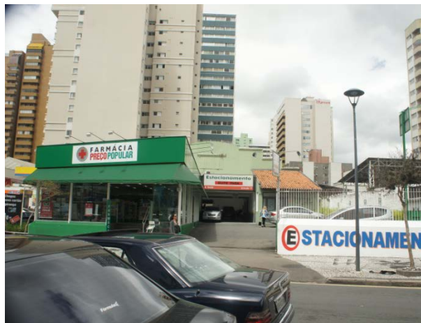
Figura 38. Estacionamento parcialmente coberto e sem área permeável
