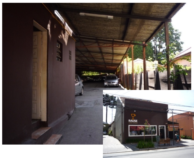
Imagem 12. Estacionamento térreo aos fundos com comércio térreo de alto padrão construtivo. Fonte: Acervo do autor.
