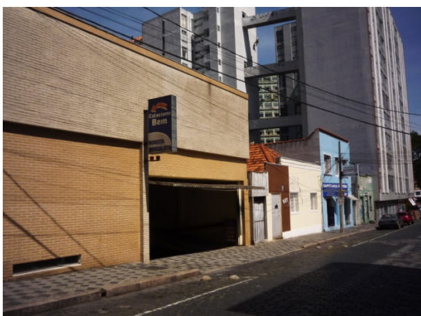
Imagem 7. Estacionamento com 2 pavimentos, coberto e fechamentos em alvenaria. Fonte: Acervo do autor.
