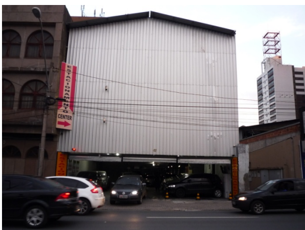
Imagem 18. Fechamento cego com chapa metálica e portão em aço. Fonte: Acervo do autor.
