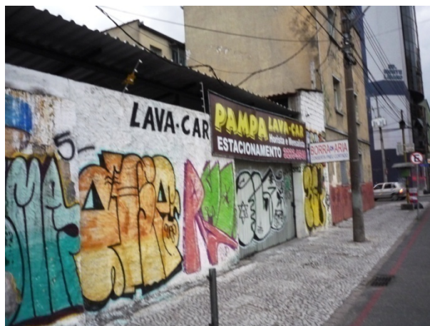
Imagem 6. Estacionamento térreo coberto e com estrutura mínima para funcionamento. Fonte: Acervo do autor.
