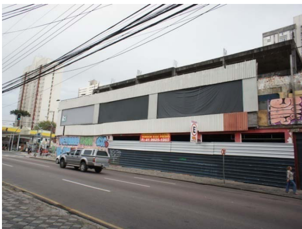
Imagem 16. Mistura de elementos de fechamentos (tapumes de madeira e metálicos com alvenaria) com característica de improvisação. Fonte: Acervo do autor.
