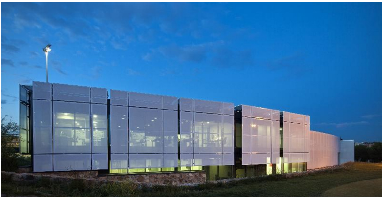
Figura 10: Aplicação da tela de Poliéster. Fonte: FERRARI (2014).
