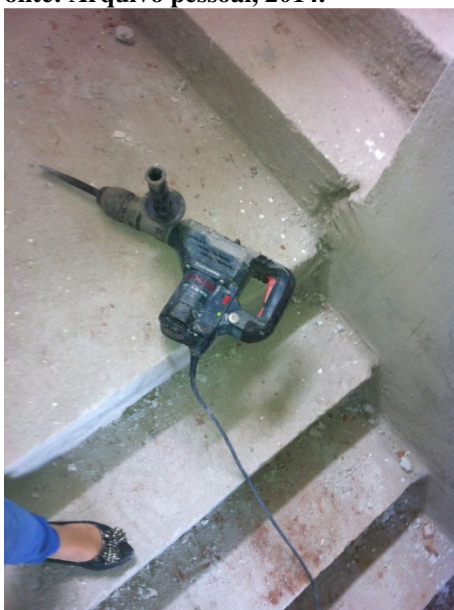
Figura 27: Ferramenta manual não guardada em local apropriado. Fonte: Arquivo pessoal, 2014.
