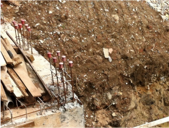
Figura 37: Vergalhões de aço com proteção. Fonte: Arquivo pessoal, 2014.
