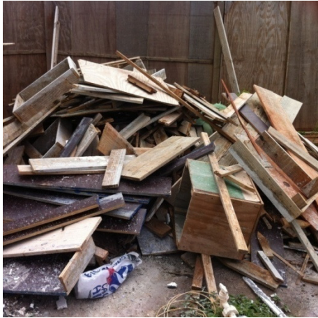
Figura 7: Madeiras não empilhadas e sem retirar ou rebater os pregos.
