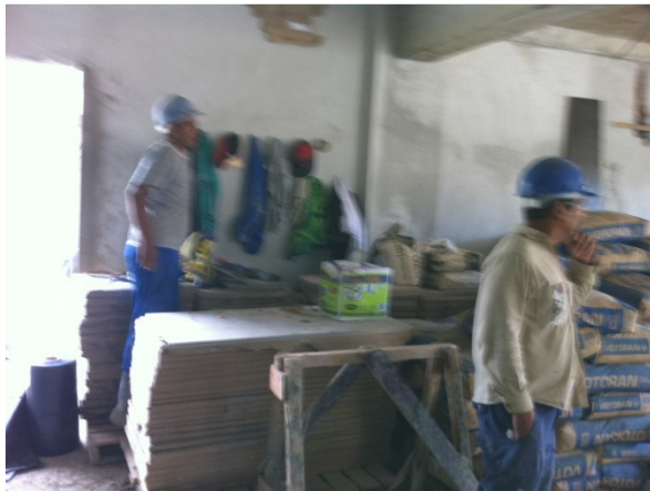
Figura 29: Materiais ocupando vias de circulação e passagem. Fonte: Arquivo pessoal, 2014.
