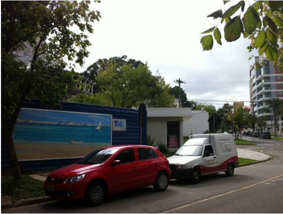
Figura 30: Tapume com 2,2 m e ocupando metade do passeio. Fonte: Arquivo pessoal, 2014.
