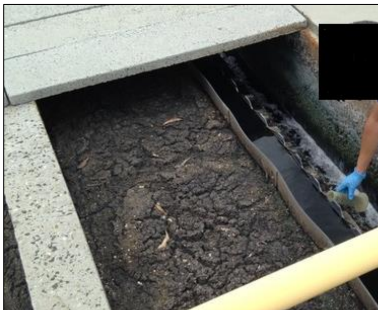
Figura 12: Coleta de esgoto na saída da canaleta do RALF pelo operador.
