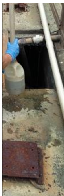
Figura 11: Coleta do esgoto depois de tratado na saída do Ralf. Fonte: o autor (2017).
