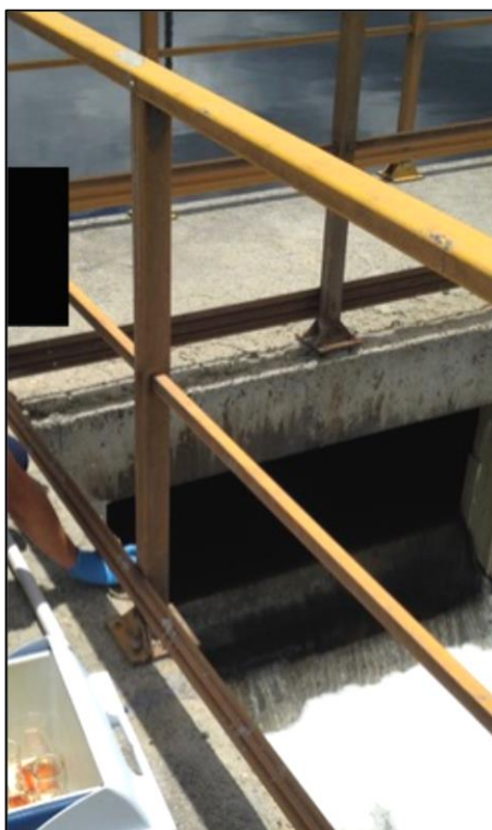
Figura 14: Coleta do esgoto pelo operador na saída da lagoa facultativa.
