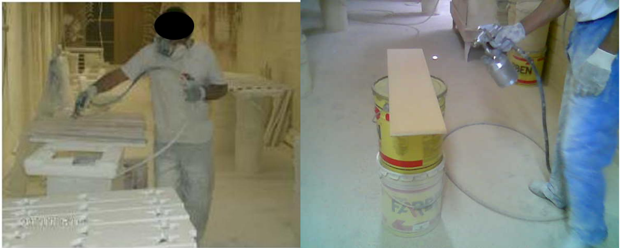
Figura 16 – Pintura PU (Poliuretano) após usinagem.
