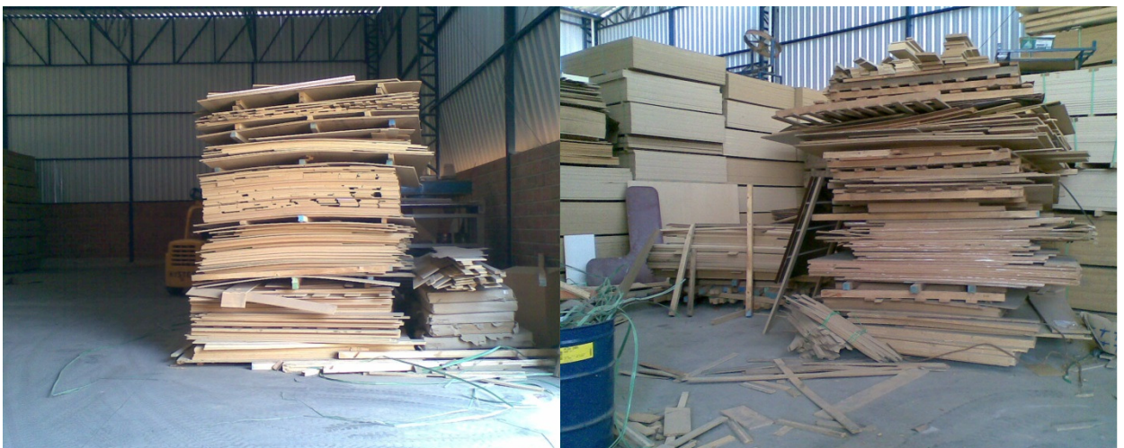
Figura 26 – Empilhamento inadequado de entulhos podendo causar acidentes envolvendo equipamentos ou pessoas.
