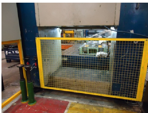
Figura 29 – Instalação da barreira física – Fonte: PPRPS da empresa XYZ
