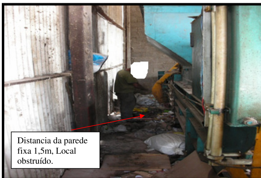
Figura 12 – Zona de Prensagem Fonte: Próprio Autor (2015).
