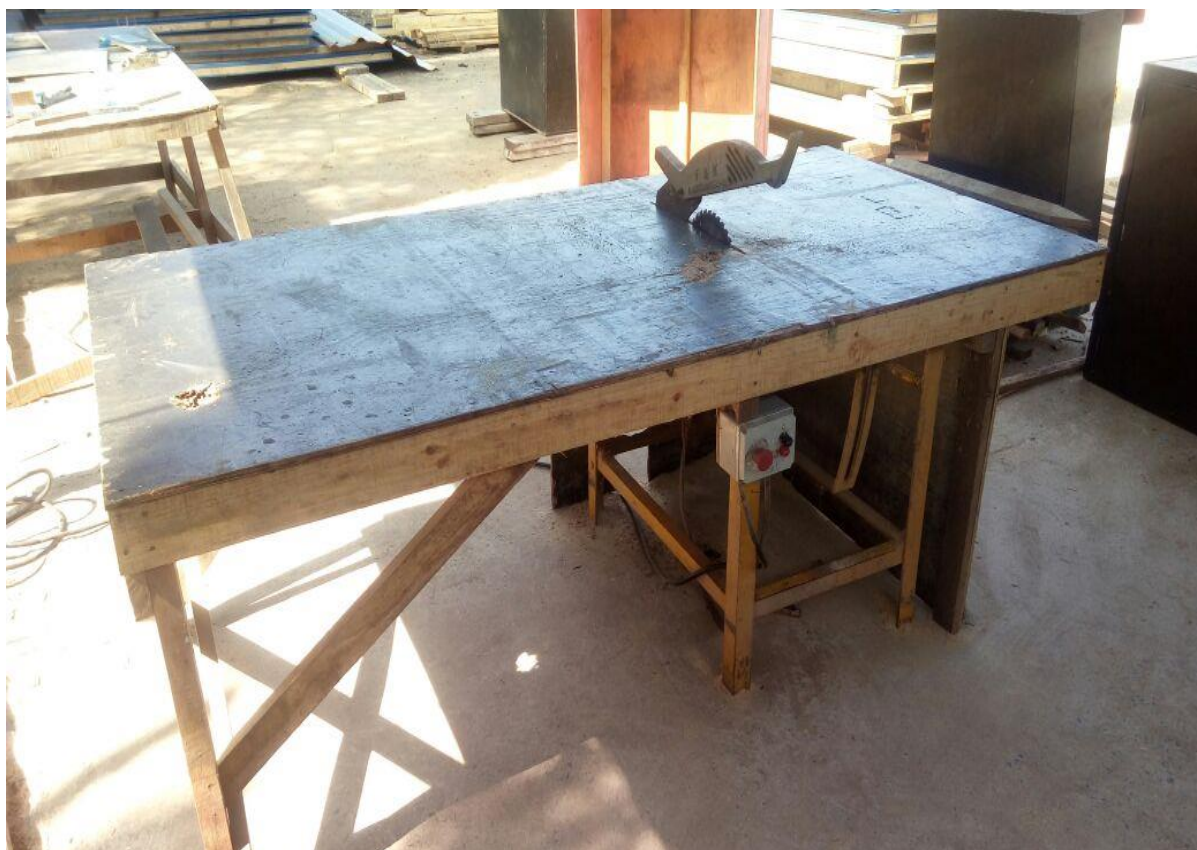
Figura 7 - Serra circular de bancada Obra 01 – Vista posterior
