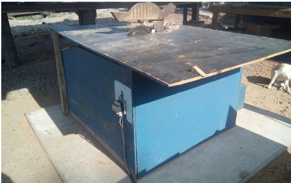
Figura 11 - Serra circular de bancada Obra 02 – Vista posterior
