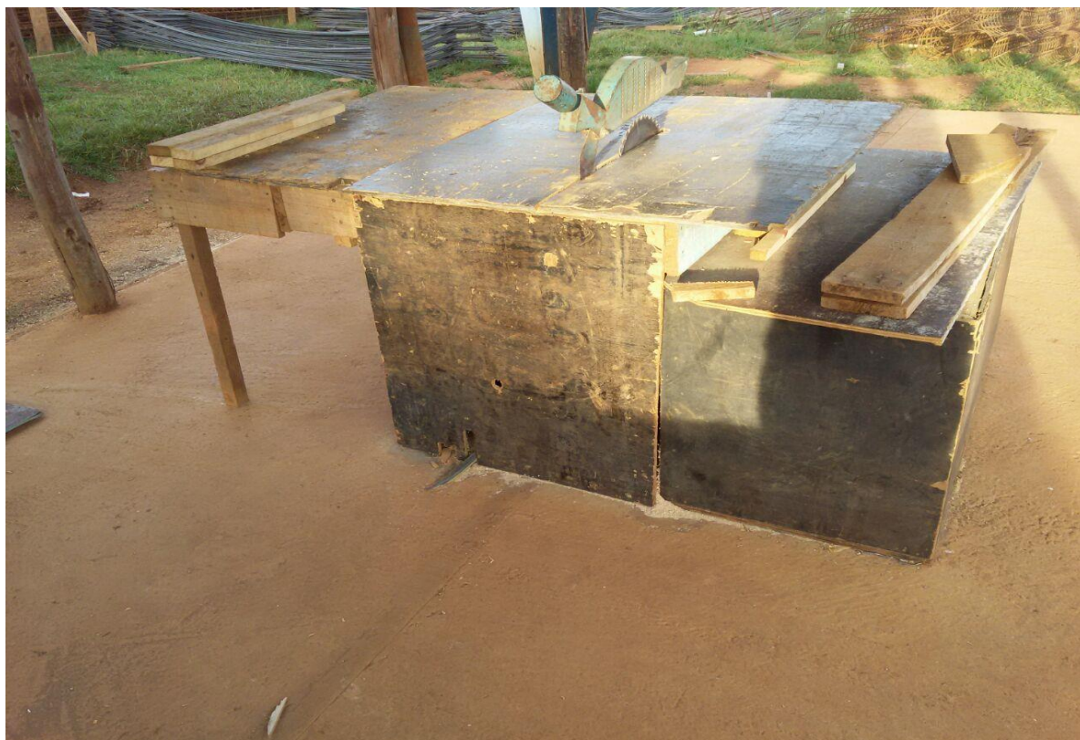
Figura 14 - Serra circular de bancada Obra 03 – Vista Anterior
