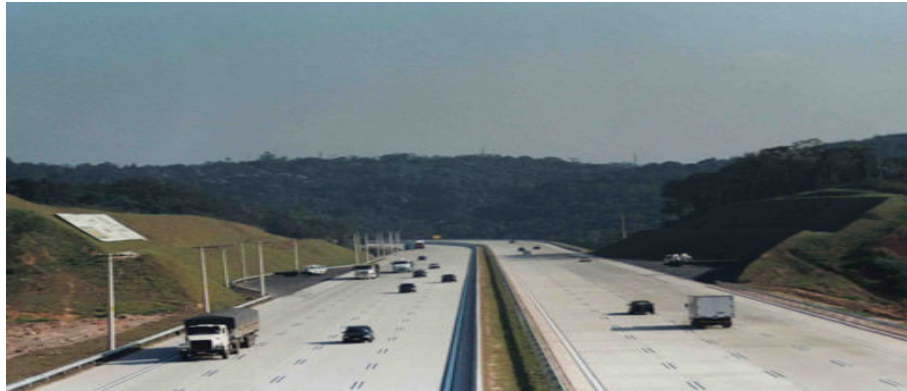
Figura 5: Pavimento de concreto de cimento
