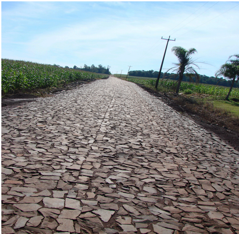
Figura 7: Calçamento de alvenaria poliédrica Fonte: Prefeitura Municipal de Missal/PR (2016)
