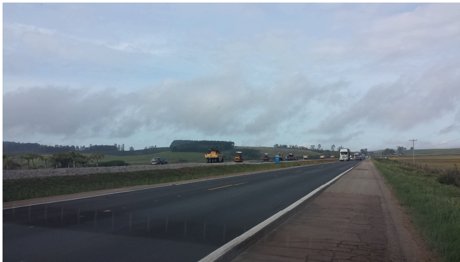
Figura 6: Pavimento de concreto betuminoso usinado a quente
