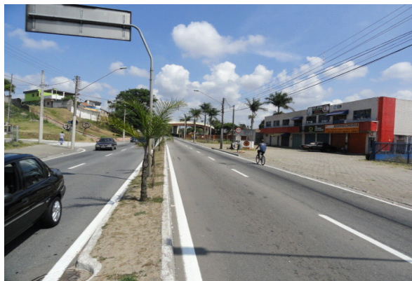
Figura 22 - Condição da Avenida Engenheiro Sebastião Gualberto Fonte: Autoria própria.
