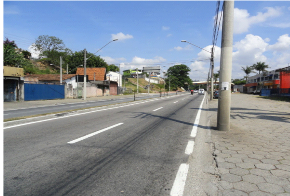
Figura 21 - Condição da Avenida Engenheiro Sebastião Gualberto Fonte: Autoria própria.
