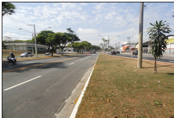
Figura 14 - Condição da Avenida Bacabal Fonte: Autoria própria.
