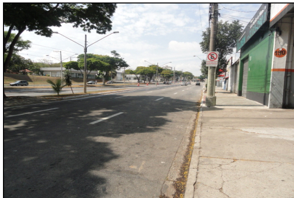
Figura 12 - Condição da Avenida Bacabal Fonte: Autoria própria.
