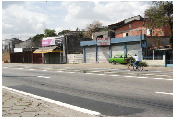
Figura 23 - Condição da Avenida Engenheiro Sebastião Gualberto Fonte: Autoria própria.
