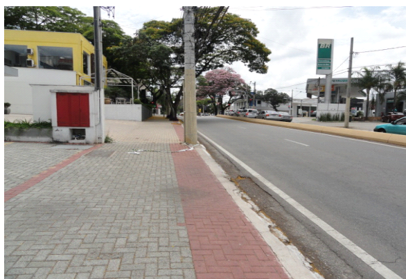
Figura 25 - Condição da Avenida São João Fonte: Autoria própria.
