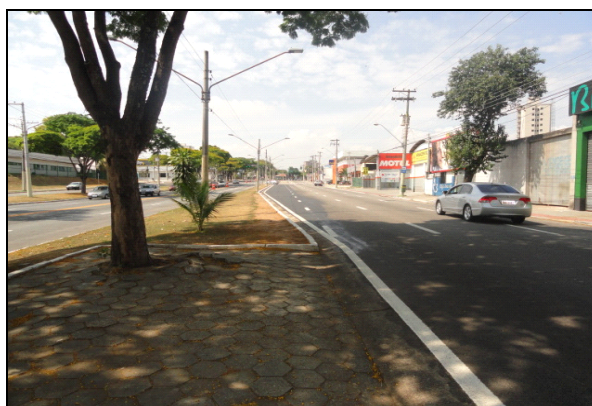
Figura 13 - Condição da Avenida Bacabal Fonte: Autoria própria.
