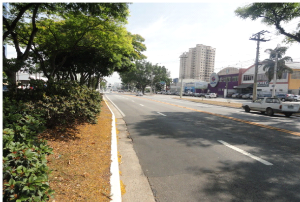
Figura 15 - Condição da Avenida Bacabal Fonte: Autoria própria.
