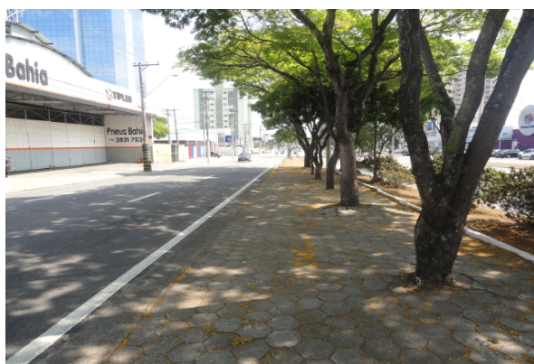
Figura 16 - Condição da Avenida Bacabal Fonte: Autoria própria.
