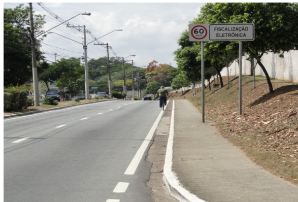
Figura 20 - Condição da Avenida dos Astronautas Fonte: Autoria própria.
