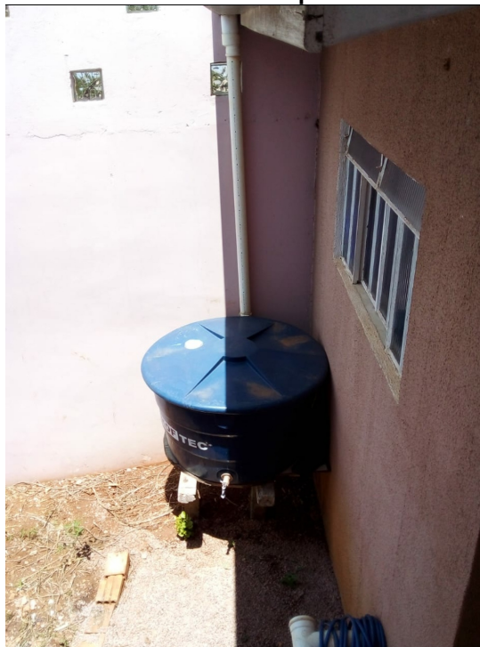
Figura 7- Cisterna construída pelo estudante em sua residência
