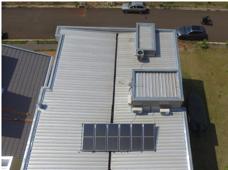
Figura 11: Telhado da residência onde será instalado o sistema fotovoltaico. FONTE: Autoria Própria.
