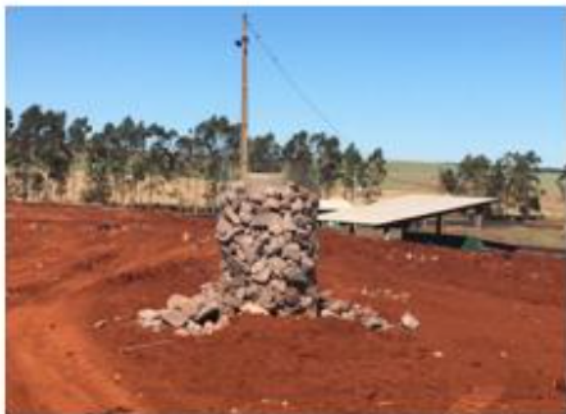
Figura 13 a-) Drenos verticais de captação do biogás no aterro, b-) Canos de condução do biogás até os moto-geradores.
