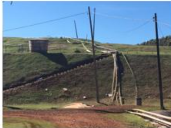
Figura 13 a-) Drenos verticais de captação do biogás no aterro, b-) Canos de condução do biogás até os moto-geradores.
