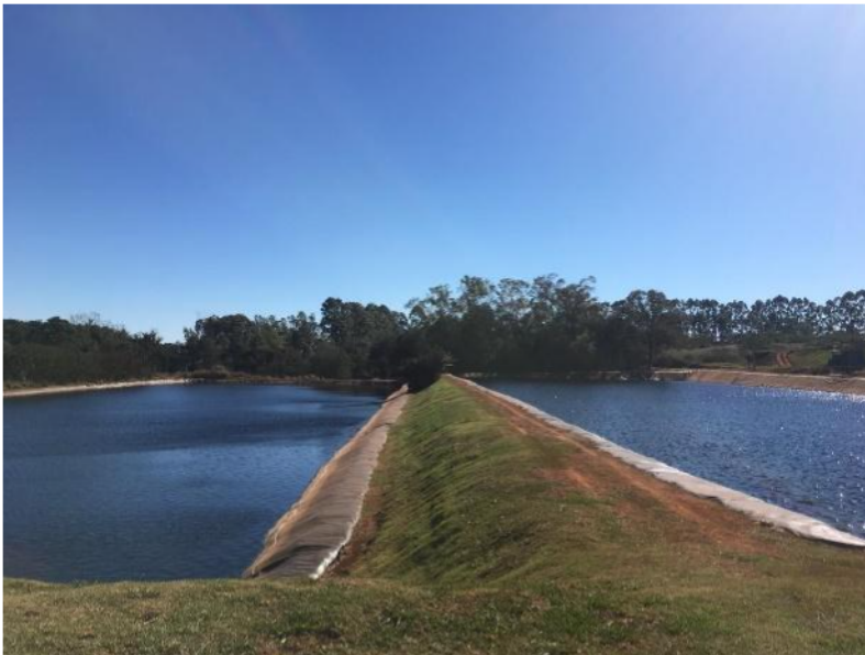
Figura 12 Lagoa facultativa do Aterro Sanitário Municipal de Cascavel – PR.
