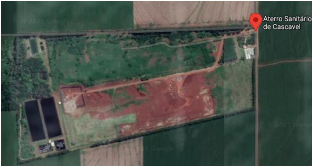
Figura 10 Aterro Municipal de Cascavel – PR. Fonte: Google maps, 2021.
