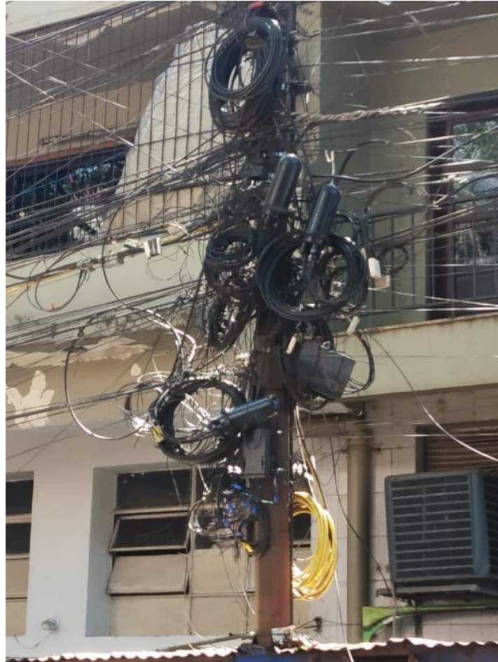
Figura 34- Instalação Incorreta
