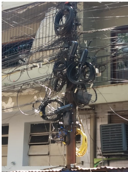
Figura 43- Instalações incorretas
