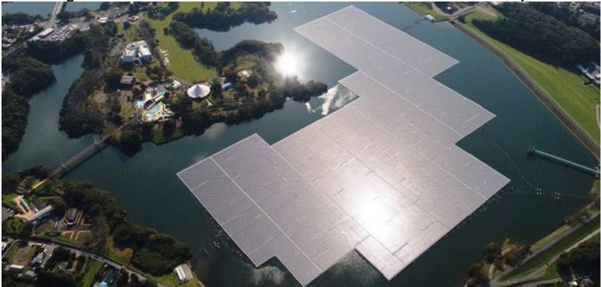
Figura 6 - Usina fotovoltaica flutuante no reservatório de Yamakura no Japão.
