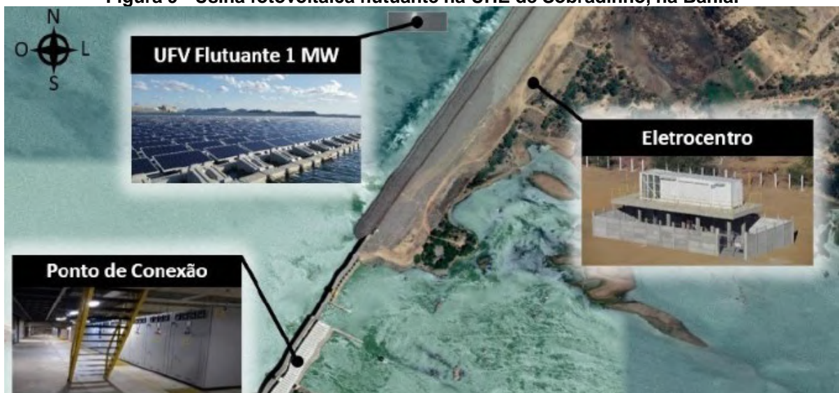
Figura 9 - Usina fotovoltaica flutuante na UHE de Sobradinho, na Bahia.
