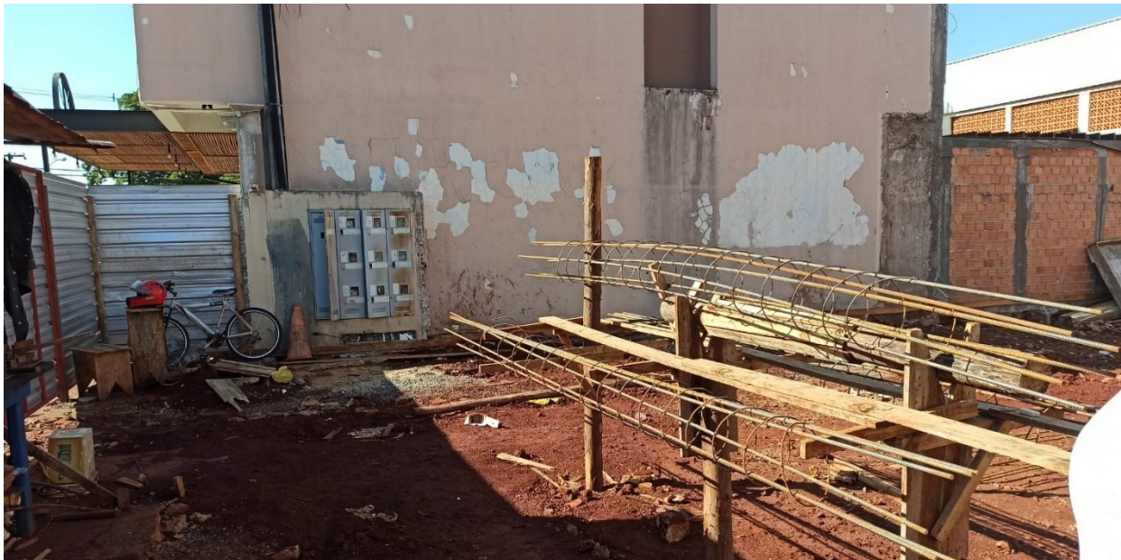
Figura 28: Etapa da obra - 1º dia
