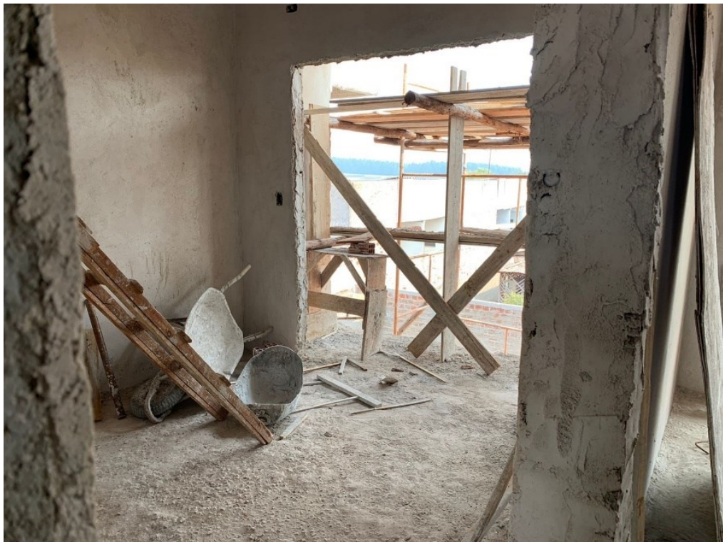
Figura 20: Etapa da obra - 1º dia
