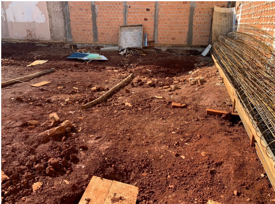
Figura 27: Limpeza do terreno - 1º dia
