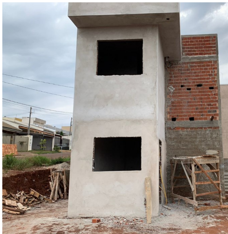
Figura 15: Etapa da obra - 2º dia
