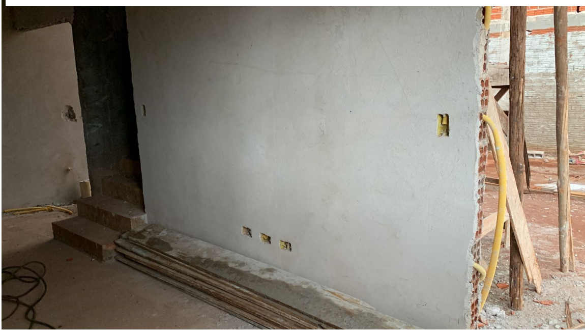
Figura 14: Etapa da obra - 1º visita
