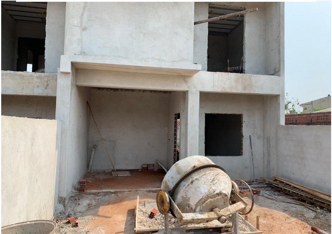
Figura 19: Etapa da obra - 1º dia
