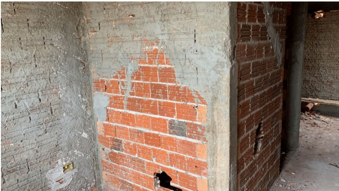
Figura 13: Etapa da obra - 1º visita
