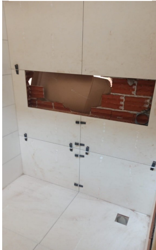
Figura 24: Etapa da obra - 3º dia
