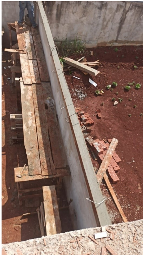
Figura 23: Etapa da obra - 3º dia
