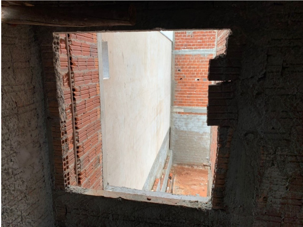
Figura 16: Etapa da obra - 2º dia
