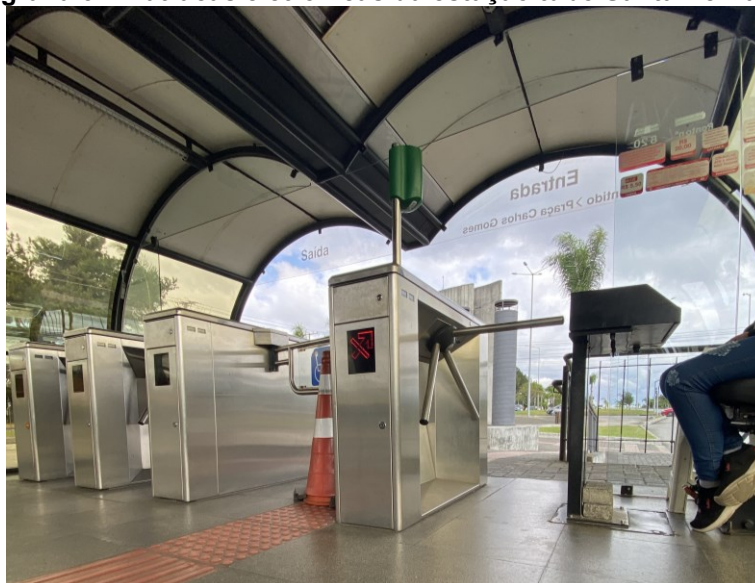
Fotografia 3 – Catracas eletrônicas da estação tubo Santa Bernadethe
