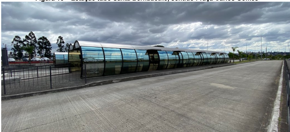
Figura 16 – Estação tubo Santa Bernadethe, sentido Praça Carlos Gomes
