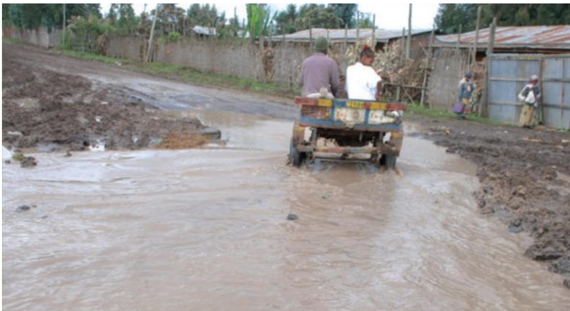
Figura 3 – Seção Inundada devido extrapolação de liquidez
