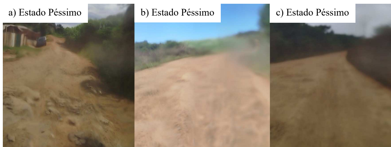
Figura 27 – a) Seção da Costa e Silva com 35,10 m/s 2 ; b) Seção da com 57,98 m/s 2 ; c) Seção da Junqueira com 38,18 m/s 2
