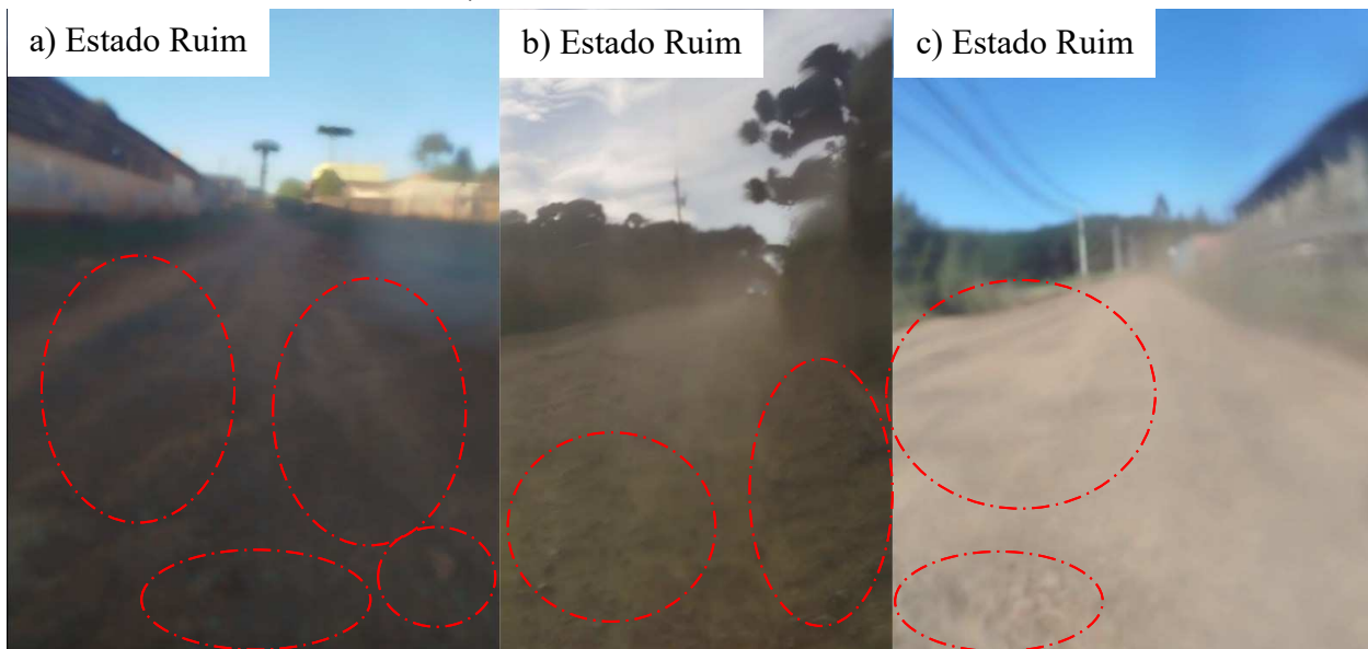
Figura 26 – a) Seção da Pardais com 28,13 m/s 2 ; b) Seção da Cláudio Coutinho com 29,37 m/s 2 ; c) Seção da Gramados com 28,46 m/s 2
