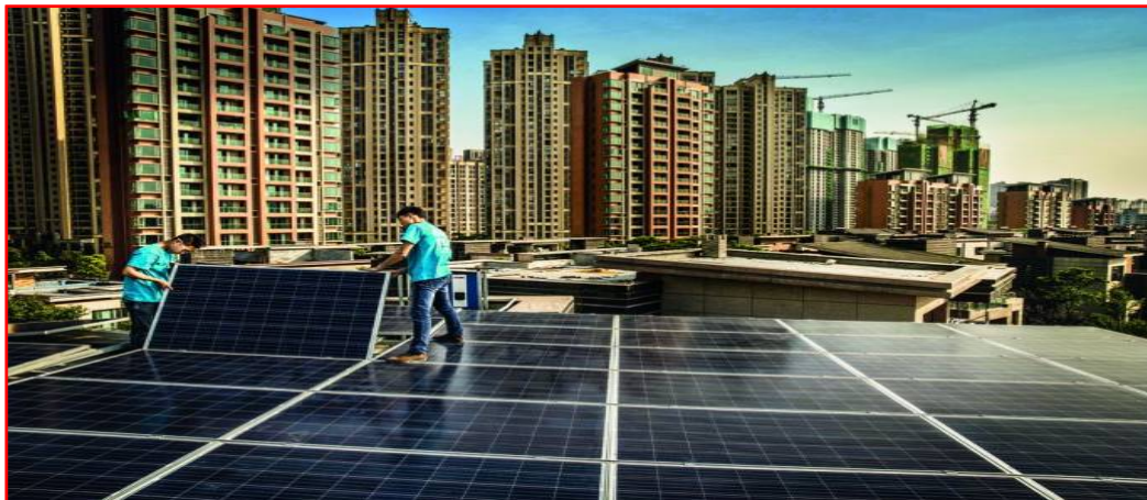
Figura 25- Homens instalando células fotovoltaicas 33 .
