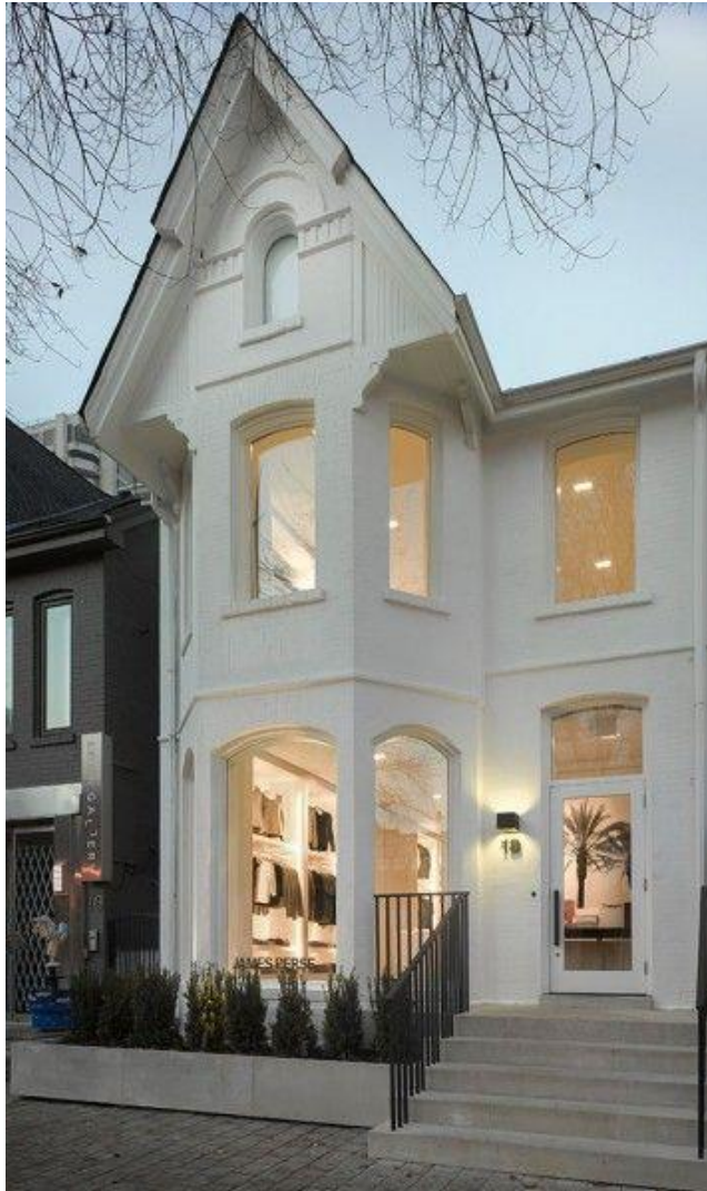
Figura 5 - Fachada da Loja
