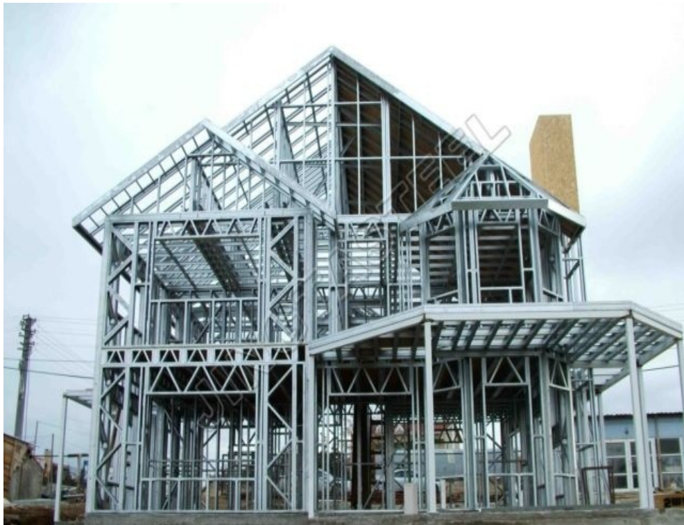
Fotografia 2 – Estrutura de residência em Light Steel Framing Fonte: Vivan, Paliari e Novaes (2012).
