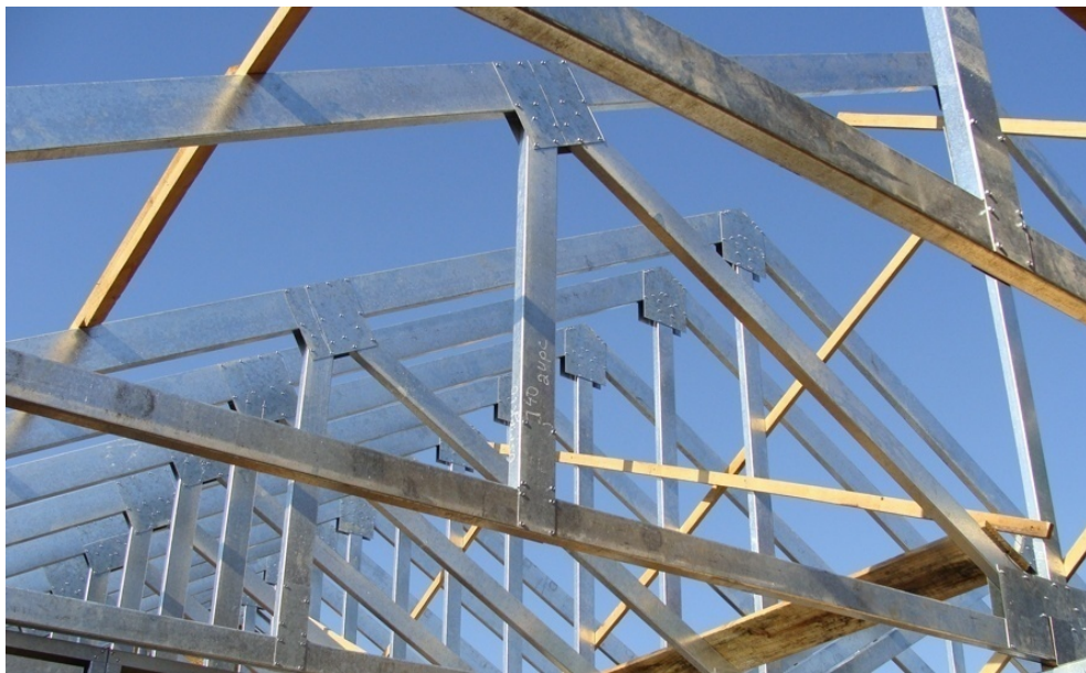
Fotografia 6 – Tesouras de telhado Fonte: Arqsteel estruturas de aço (2013).
