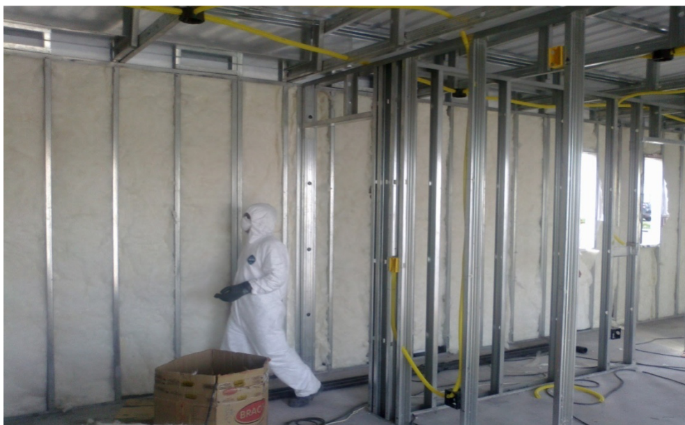
Fotografia 8 – Instalação de Lã mineral em painéis Fonte: Rayol (2012).
