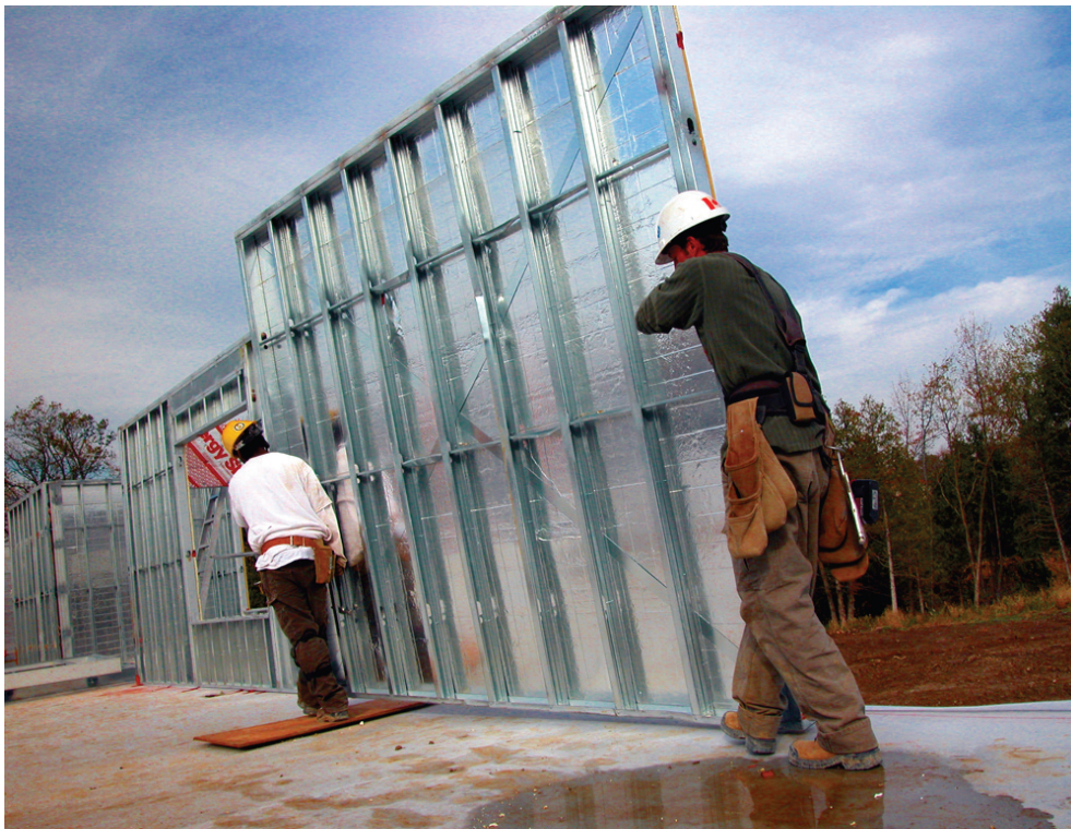
Fotografia 3 – Painel estrutural em Light Steel Framing
