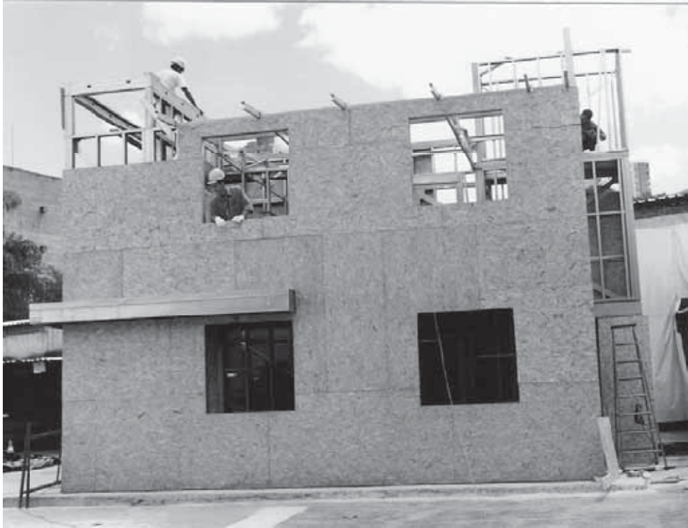
Fotografia 7 – Fachada com fechamento externo em OSB Fonte: Manual Steel Framing: Arquitetura (2012, p. 80).
