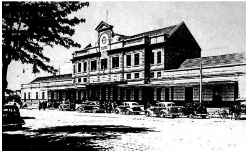
Figura 16: Vista da Estação Ferroviária de Curitiba. Início século XX Fonte. FCC.
