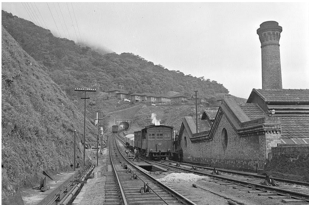
Figura 5: Vista externa de uma casa de máquinas. - Serra do Mar - SP
