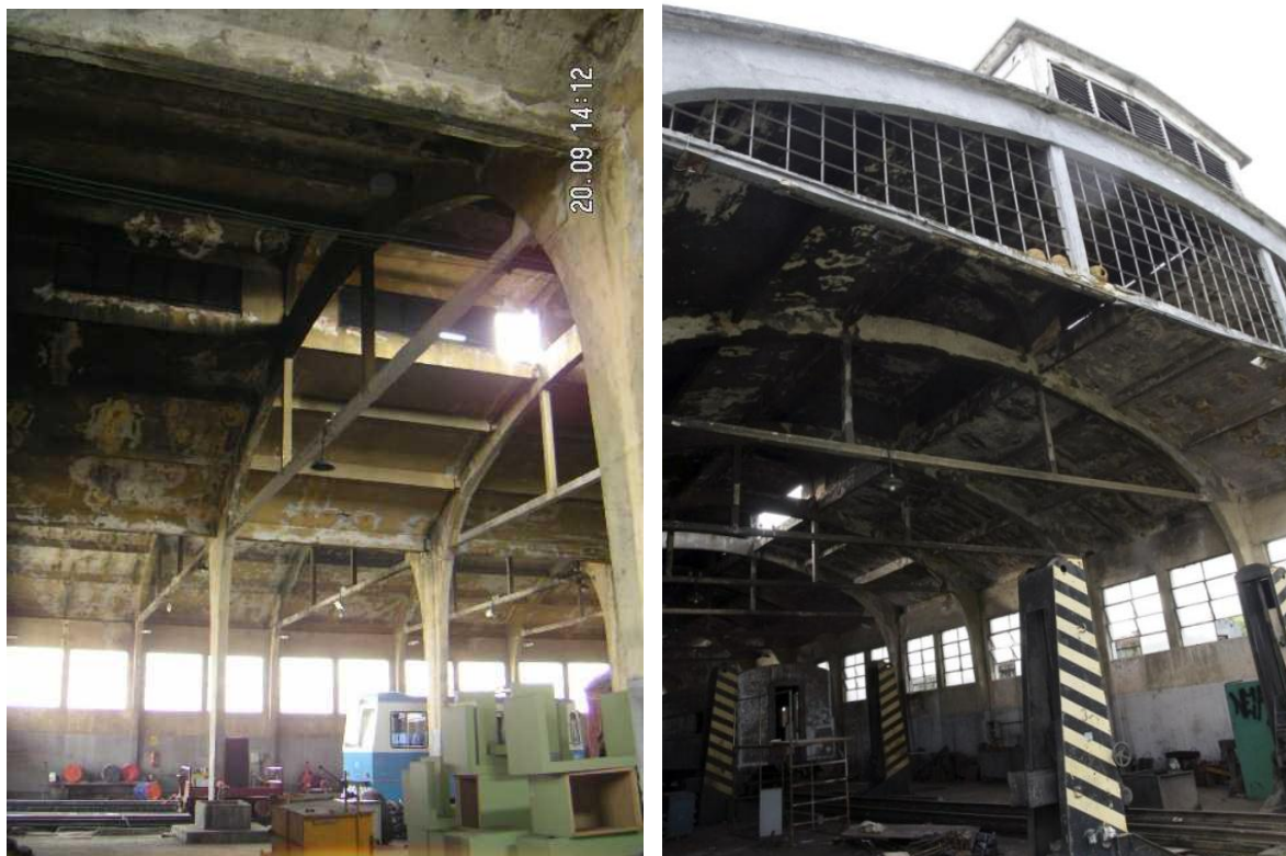
Figura 103: Depósito de Máquinas e Litorinas. Vistas internas Fonte: Acervo SEEC.
