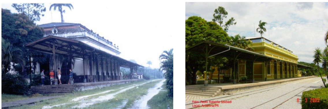
Figura 57: Estação Férrea Antonina – 1997 e a Estação Antonina - 2003. Após Restau Foto: Júlio Carone (esq.) e Paulo R. Szabadi (dir.)
