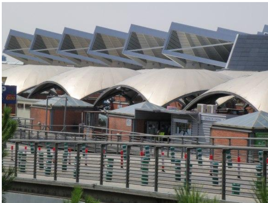
Figura 74: Nova Estação de Metrô de Atocha – Anexo à Porta de Atocha. Fonte: https://umbrasileironaespanha.wordpress.com
