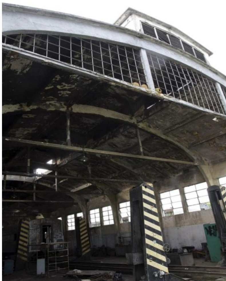
Figura 52: Depósito de Máquinas e Litorinas.
