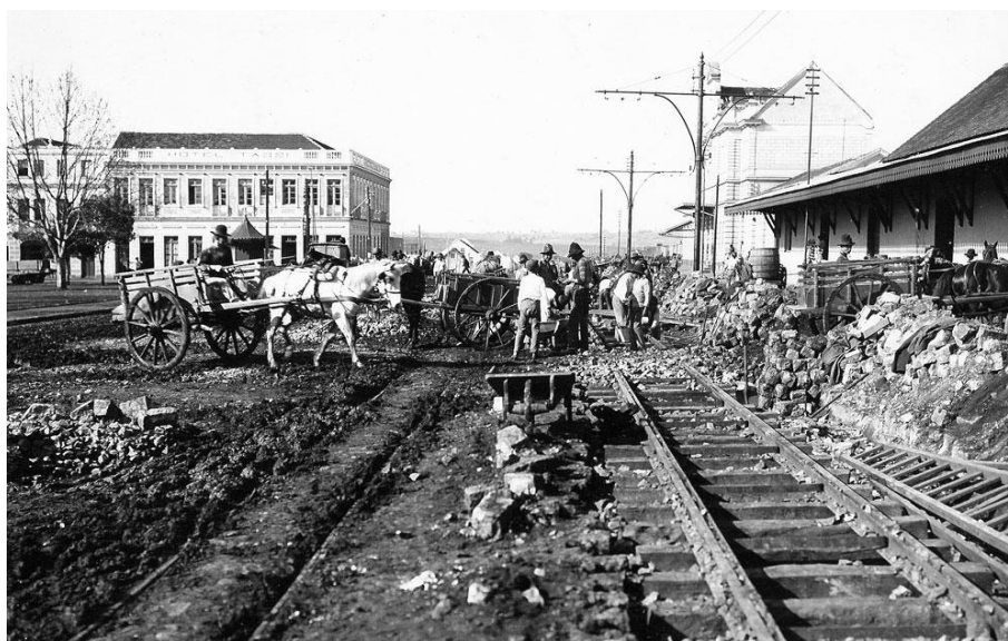
Figura 10: Assentamento de Trilhos para o Bonde Fonte: Fundação Cultural de Curitiba - FCC
