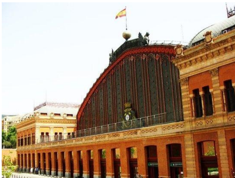
Figura 70: Estação Ferroviária de Atocha - Madri /Espanha Fonte: www.repository.utl.pt/bitstream/10400.5/5447/1
