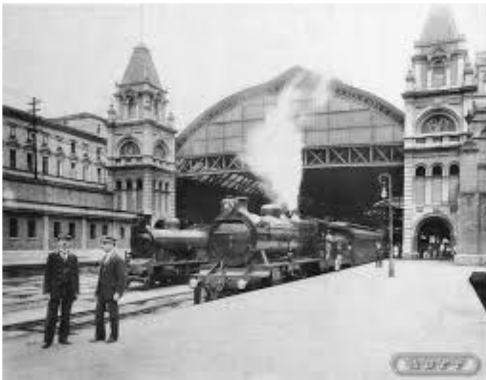
Figura 7: Estação da Luz – SP
