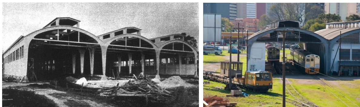
Figura 48: Depósito de Locomotivas da RFFSA - 1943 em Construção / à dir. - 2013
