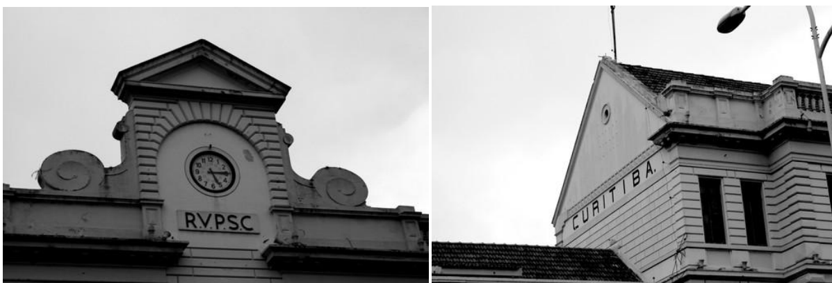
Figura 38: Detalhes do frontão e Detalhe da Cobertura da Estação Ferroviária.
