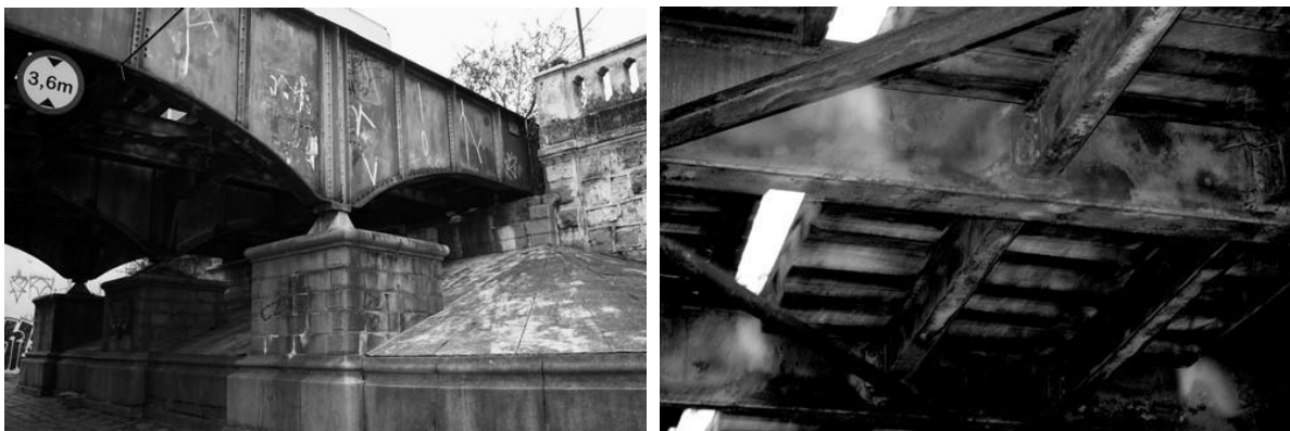
Figura 63: Detalhes da Ponte Preta sobre a Rua João Negro. Fonte. Florenzano, 2012.
