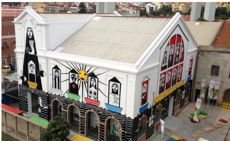
Figura 80: LX Factory - Vista de um dos Pavilhões do Complexo Fonte: http://www.tripadvisor.com.br
