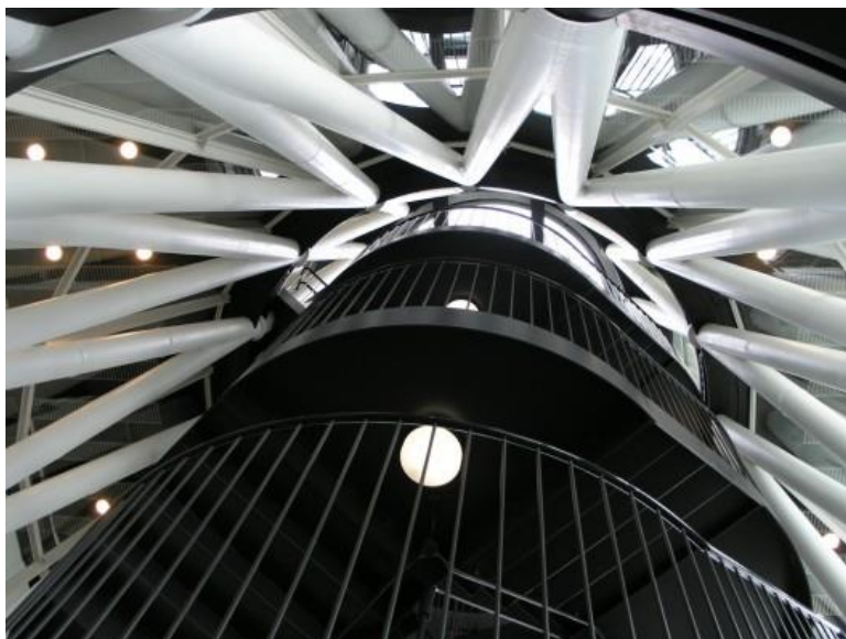
Figura 13: Estrutura com tubos e uma das escadas Fonte: www.archdaily.com.br
