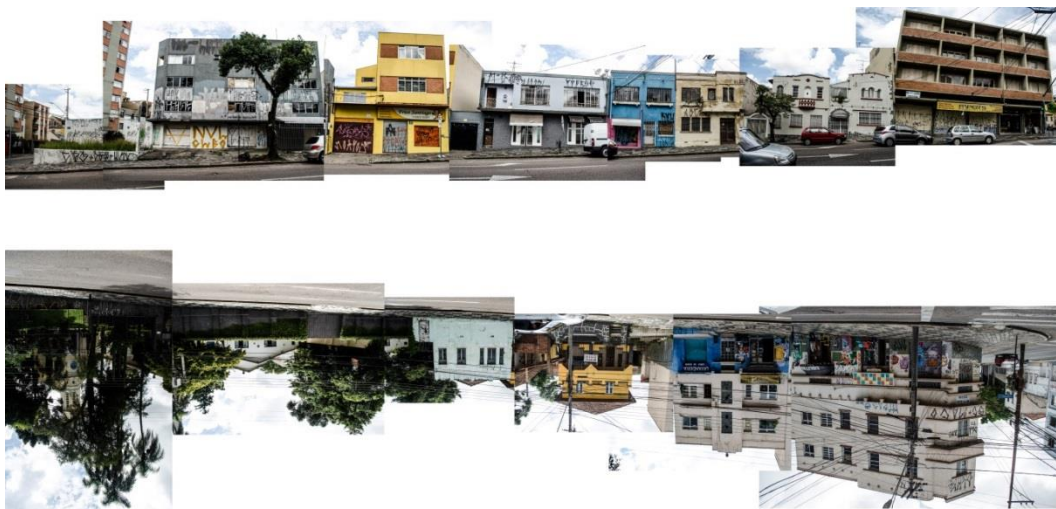
Figura 35 - Montagem fachadas Rua Trajano Reis. Fonte: Autoria Própria.
