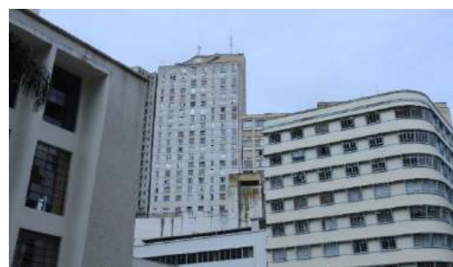
Figura 26 - Fotografia da sobreposição de edifícios a partir da rua Cândido Lopes
