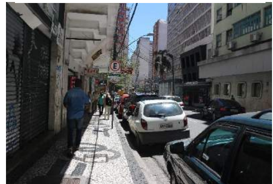
Figura 27 - Foto da largura da calçada da rua Cândido Lopes
