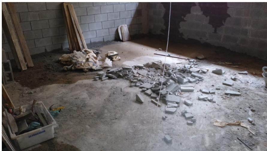
Figura 15 – Limpeza, preparação, e organização do pavimento. Fonte: Acervo próprio.
