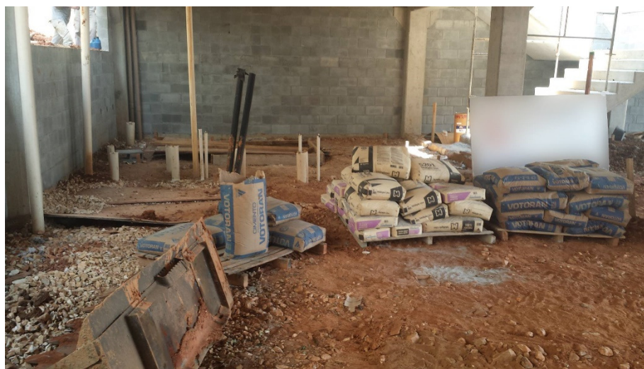
Figura 6 – Armazenamento de materiais. Fonte: Acervo próprio.
