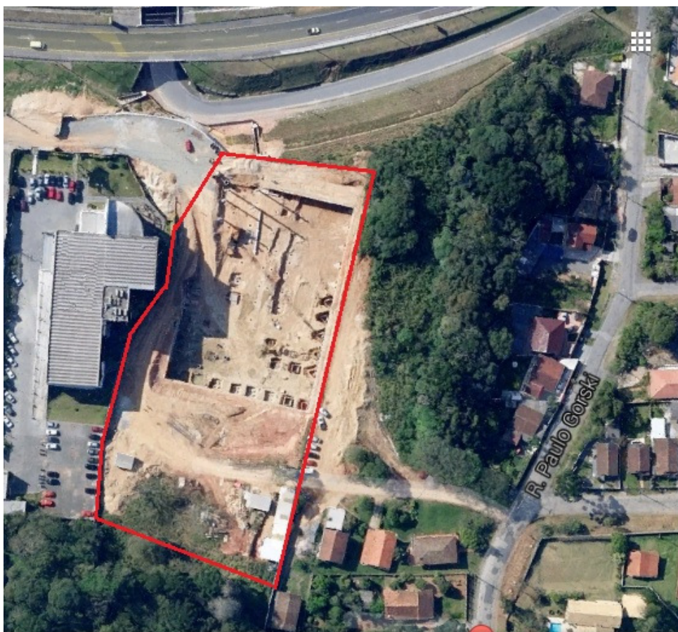
Figura 5 – Terreno da obra de estudo. Fonte: Google Earth.
