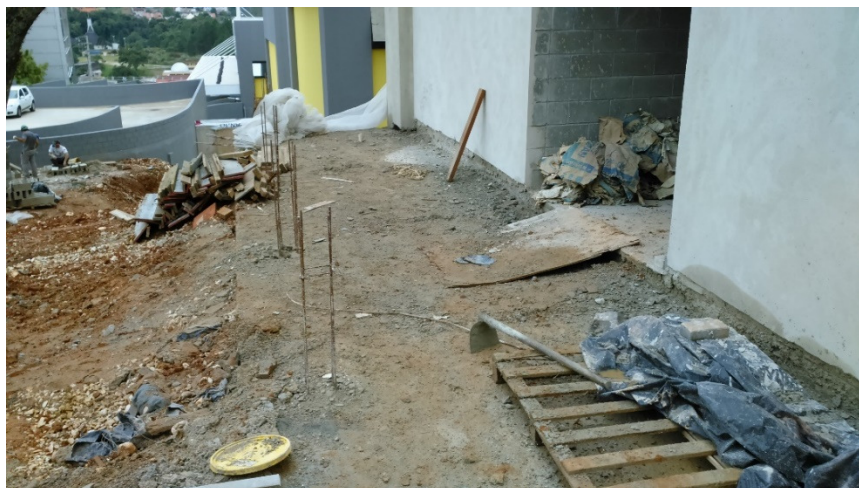
Figura 18 – Acondicionamento de resíduos pós uso. Fonte: Acervo próprio.
