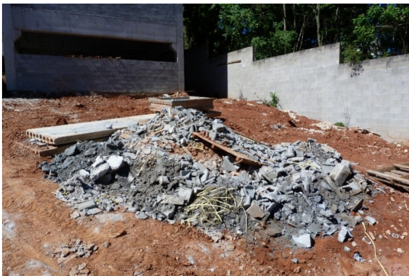
Figura 8 – Disposição de resíduos de blocos de concreto no canteiro. Fonte: Acervo próprio.
