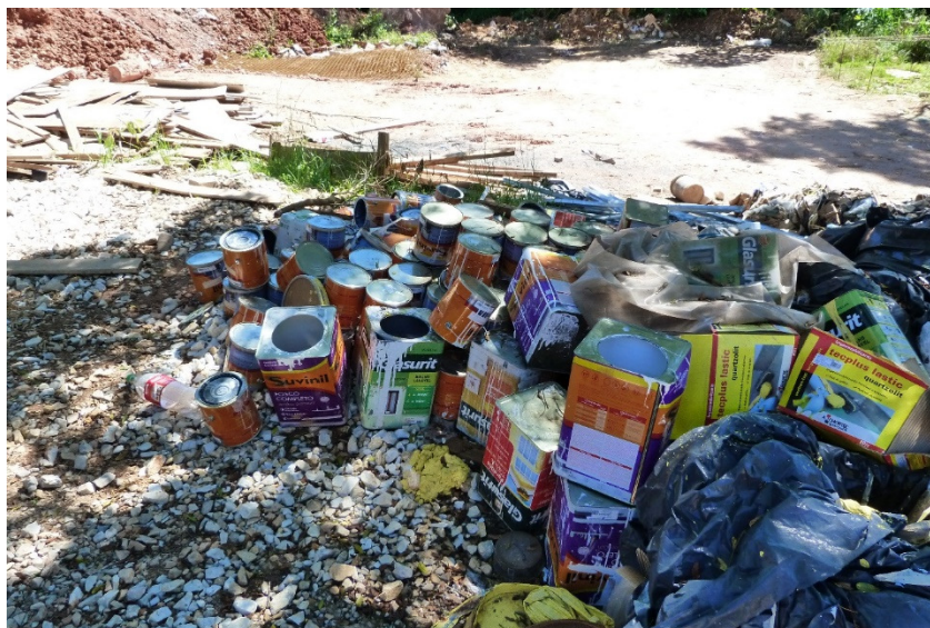
Figura 10 – Disposição de resíduos classe D no canteiro. Fonte: Acervo próprio.
