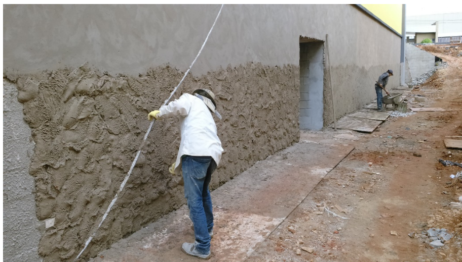
Figura 22 – Reutilização de argamassa. Fonte: Acervo próprio.
