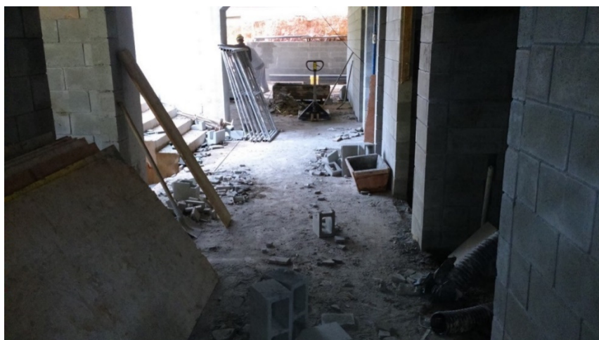
Figura 14 – Situação do pavimento durante a execução dos serviços. Fonte: Acervo próprio.
