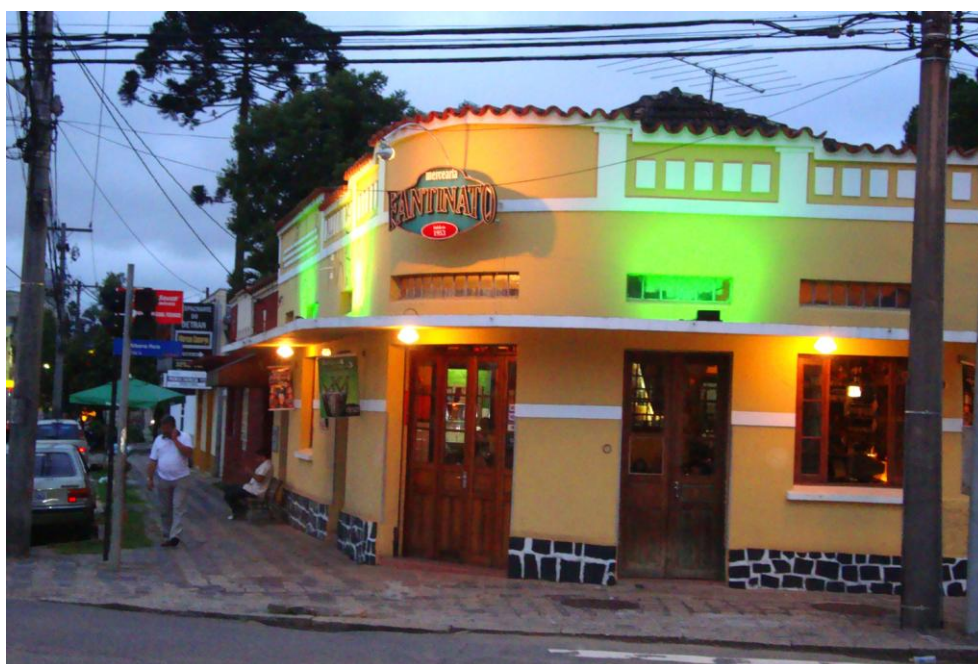
Figura 16 – Fachada do Empório Fantinato em Curitiba (PR)
