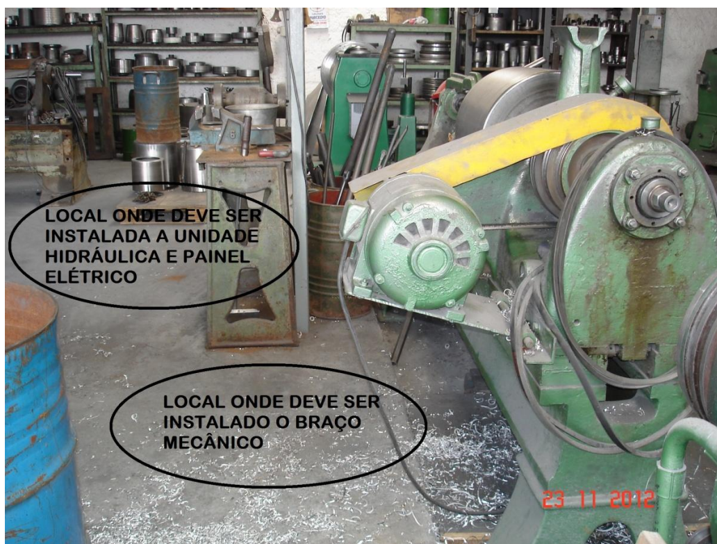
Figura 32 - Local de instalação do braço mecânico (parte frontal). Fonte: Autoria própria (2012).
